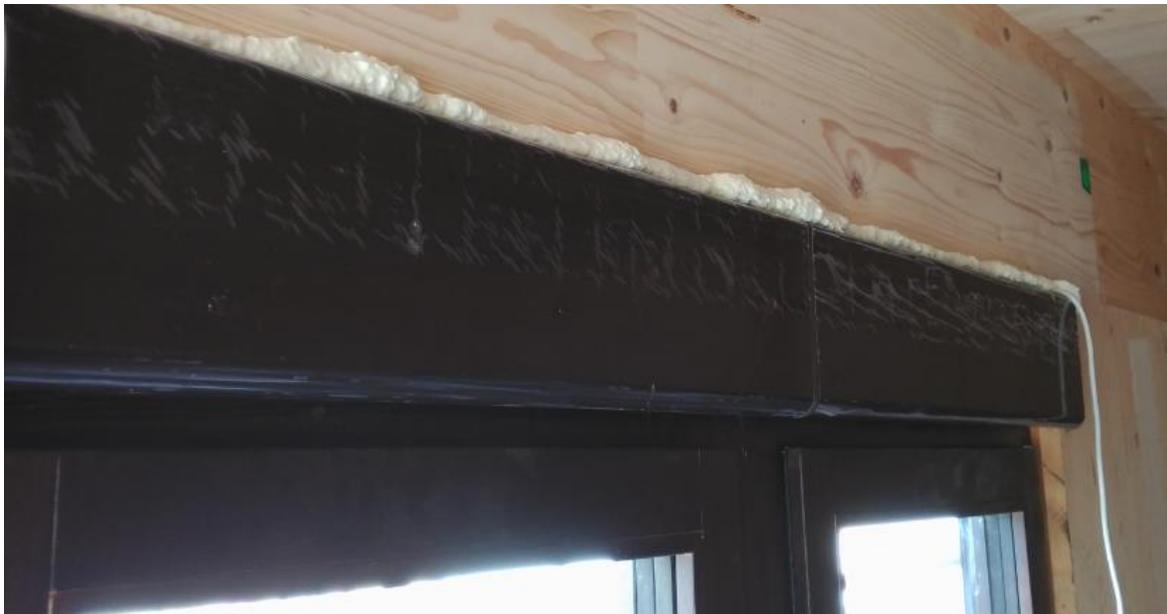
**Imagen 18. Detalle de instalación de las persianas eléctricas con aislamiento interior y sellado en la junta con la estructura con espuma de poliuretano**
