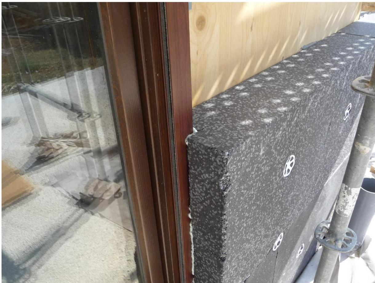
**Imagen 12. Detalle constructivo de la fachada: aislamiento de EPS en el zócalo hasta 1m de altura, en el encuentro con la carpintería de madera.**
