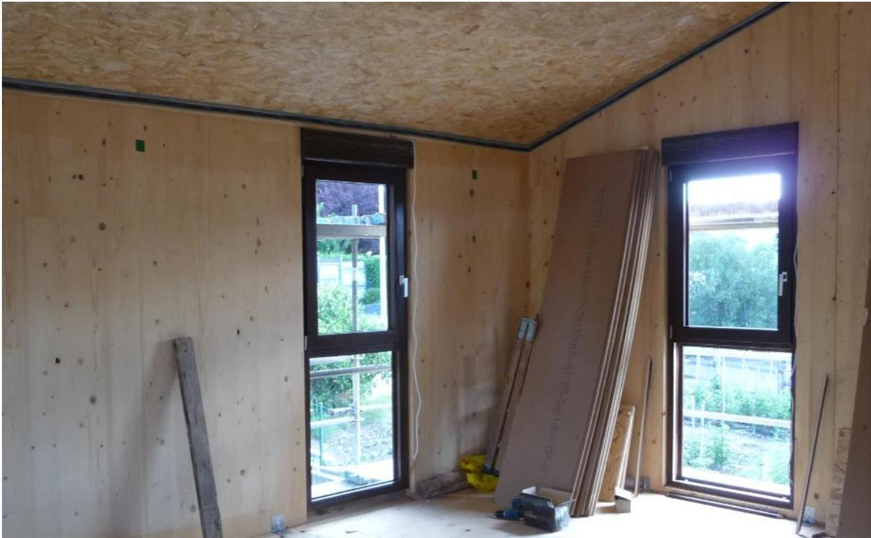
**Imagen 17. Carpintería exterior de madera instaladas sobre la estructura de panel contralaminado de madera de CLT.**
