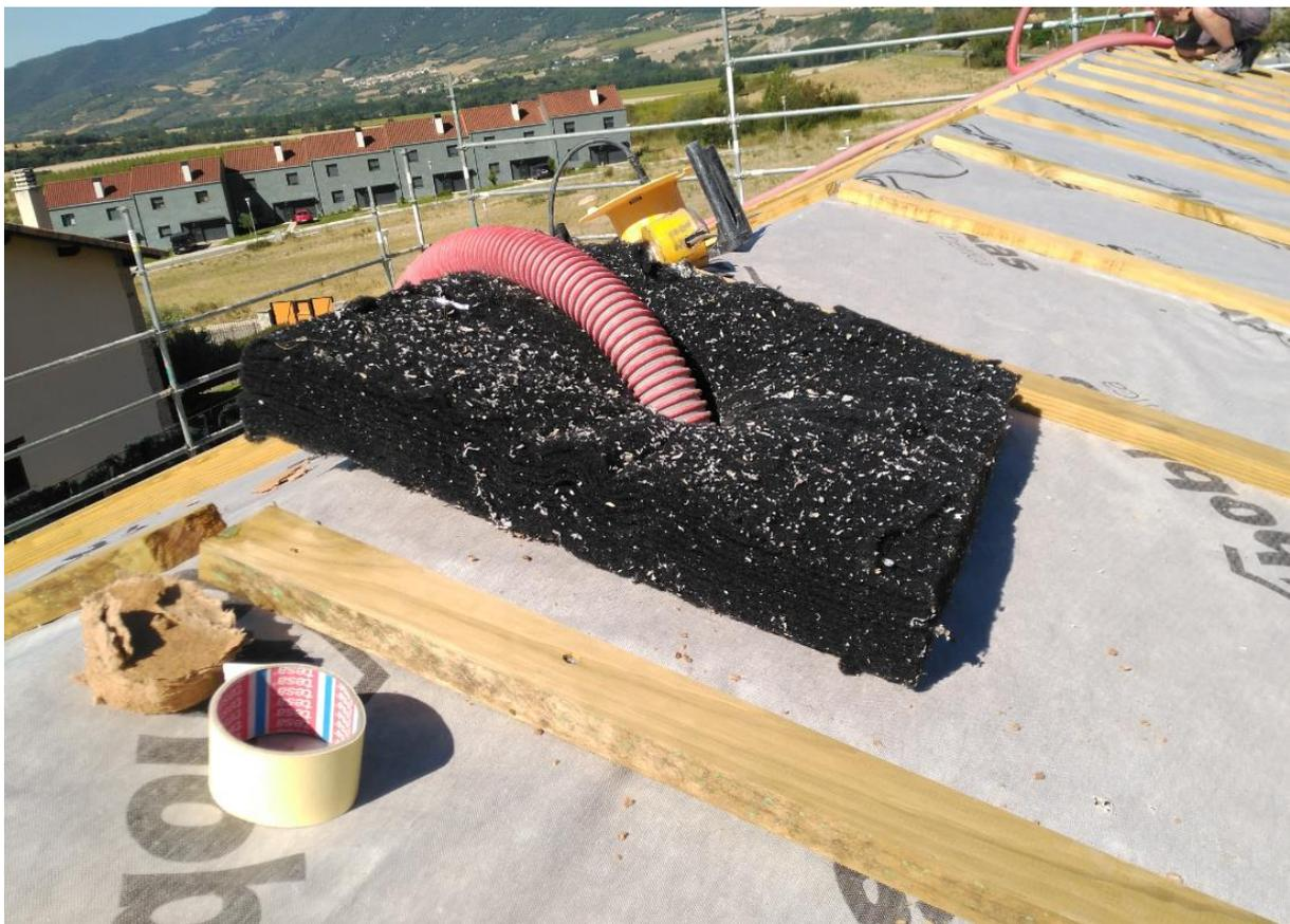
Imagen 15. Insuflado de celulosa desde la cara superior de la cubierta
