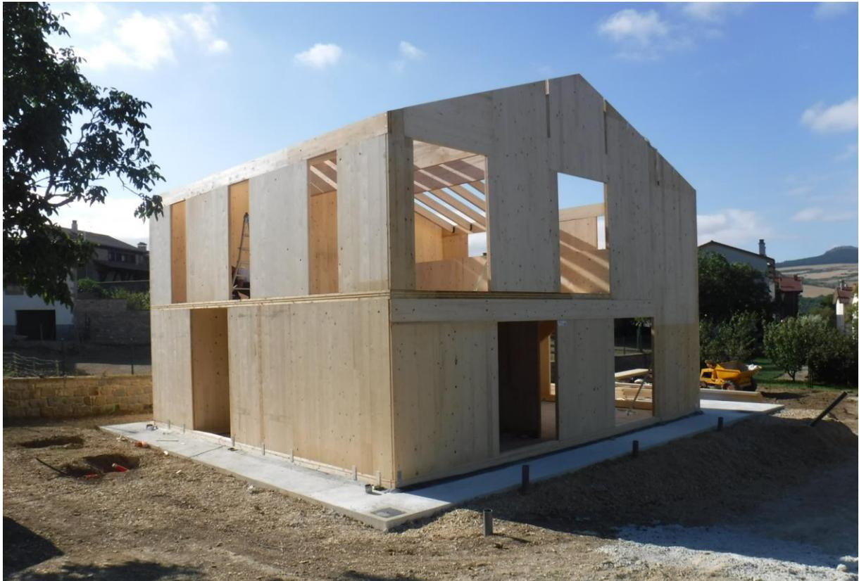
**Imagen 3. Estructura de madera contralaminada (CLT) en fachadas y cubierta de madera laminada encolada.**
