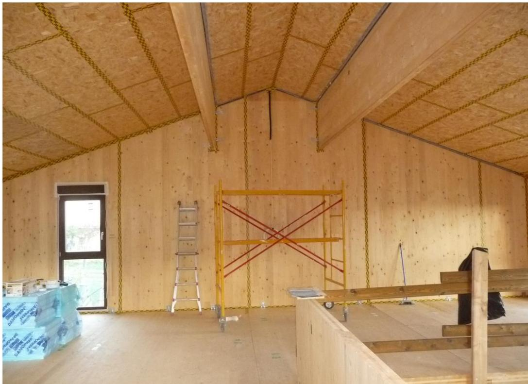
**Imagen 19. Detalle de ejecución de la hermeticidad en la cara interior de la estructura: Sellado de juntas en fachada y cubierta con cinta hermética para interior**
