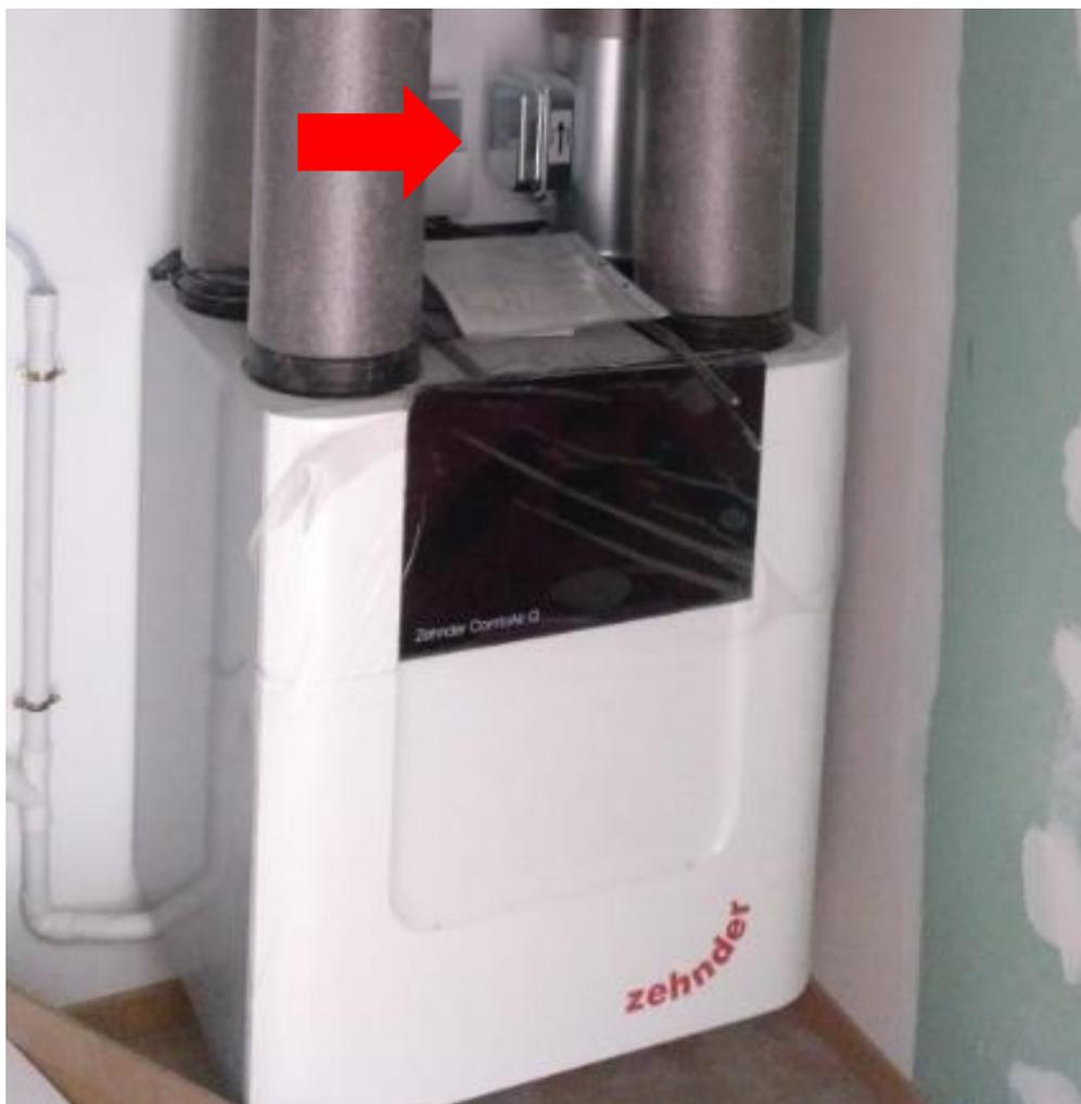
**Imagen 24. Resistencia eléctrica para atemperado del aire de impulsión en invierno**
