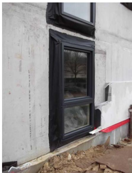
Les traversées de l'enveloppe pour les arrivées de fourreaux en pénétration et les sorties de ventilation en toiture sont également traitées en étanchéité à l'air.
