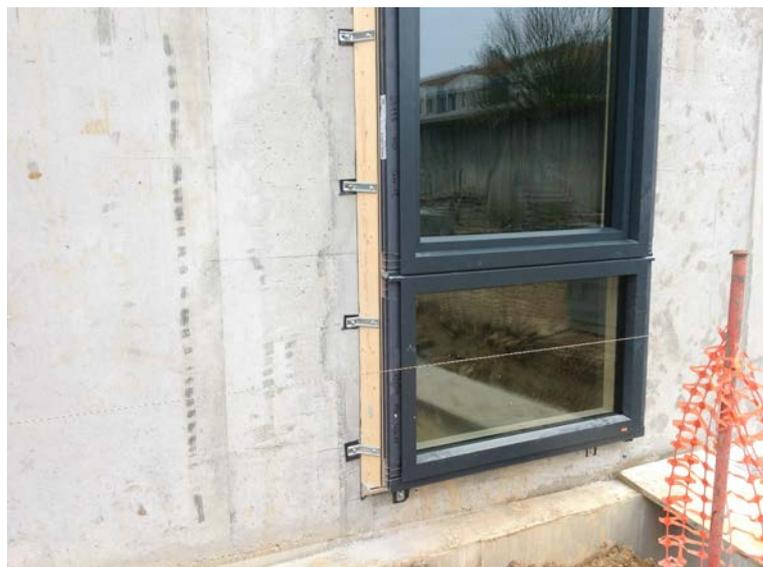
Pose menuiserie sur la façade béton
