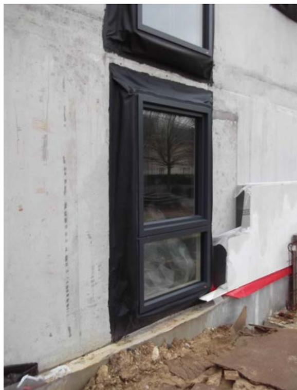
Traitement étanchéité à l'air des menuiseries sur façade béton
