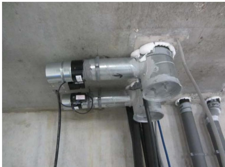
Pied de colonne VMC. Etanchéité en traversée de plancher
