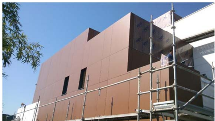
AISLAMIENTO XPS (160MM) y BARRERA en ENVOLVENTE EXTERIOR
