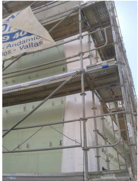
AISLAMIENTO XPS (160MM) y BARRERA en ENVOLVENTE EXTERIOR
