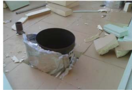
ADAPTACIÓN de PLACAS AISLANTES XPS a CLARABOYAS, BAJANTES etc.
