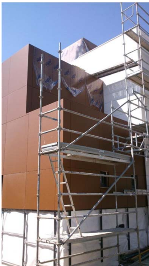
AISLAMIENTO XPS (160MM) y BARRERA en ENVOLVENTE EXTERIOR
