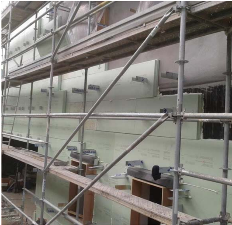
AISLAMIENTO XPS (160MM) y BARRERA en ENVOLVENTE EXTERIOR
