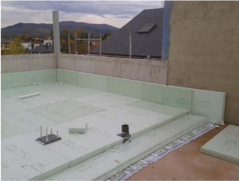
ADAPTACIÓN de PLACAS AISLANTES XPS a CLARABOYAS, BAJANTES etc.
