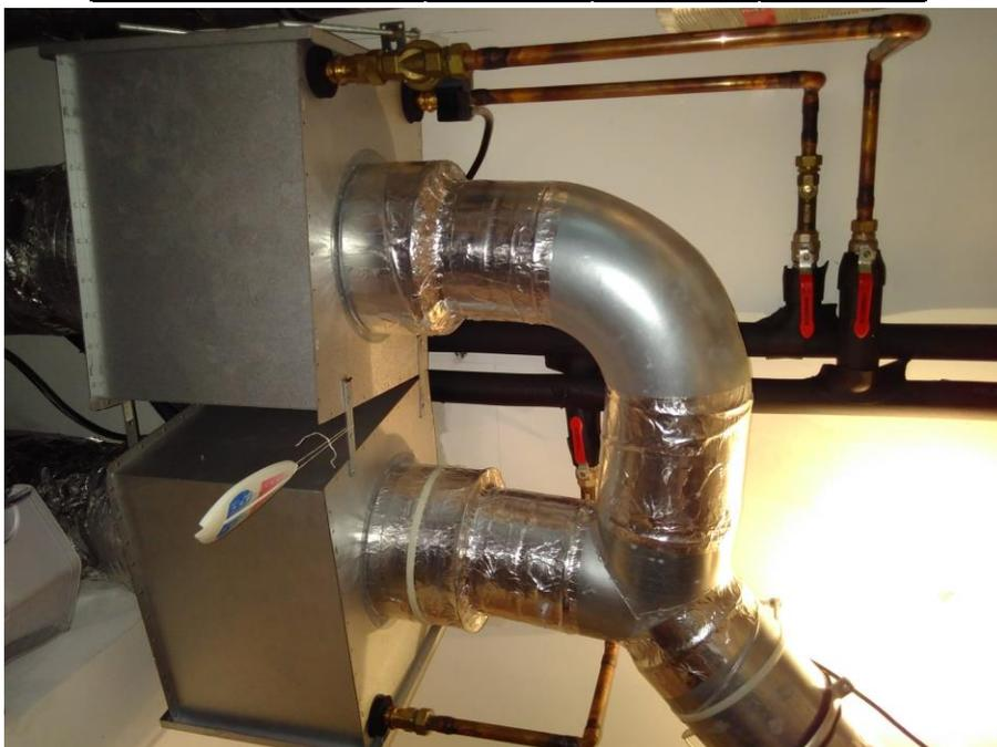
La production d'ECS est assurée par un autre ballon thermodynamique sur air extérieur de type XIROS 150L
