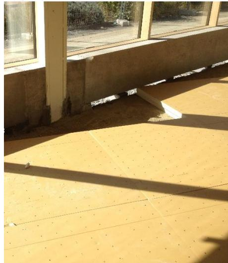
L'isolant de sol a été disposé sous le dallage, y compris dans la zone de stockage avec les racks.
