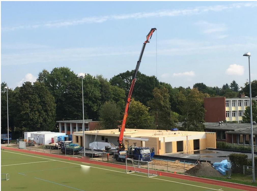
Das Gebäude im Bau. Es wurde in der Werkstatt als Holzrahmenbau vorgefertigt und Zug um Zug vor Ort zusammengesetzt.
