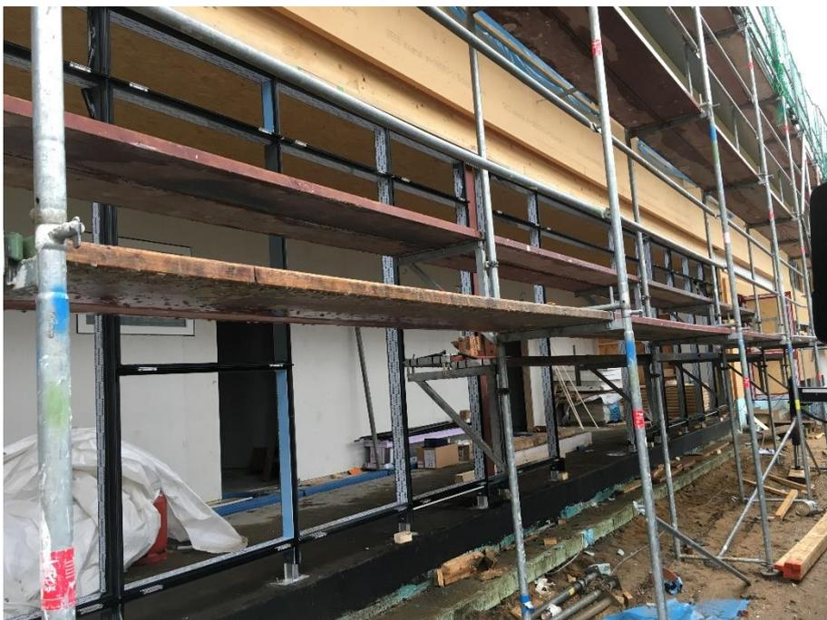
Für die Pfosten-Riegel-Fassade kam die Heroal C 50 HI, mit passivhaustauglichen Isolatoren im Bereich der Pfosten und Riegel, Uf 0,96, Ug 0,60, G-Wert 62% (Dreifach-Verglasung, Kunststoff-Abstandhalter) zum Einsatz.
