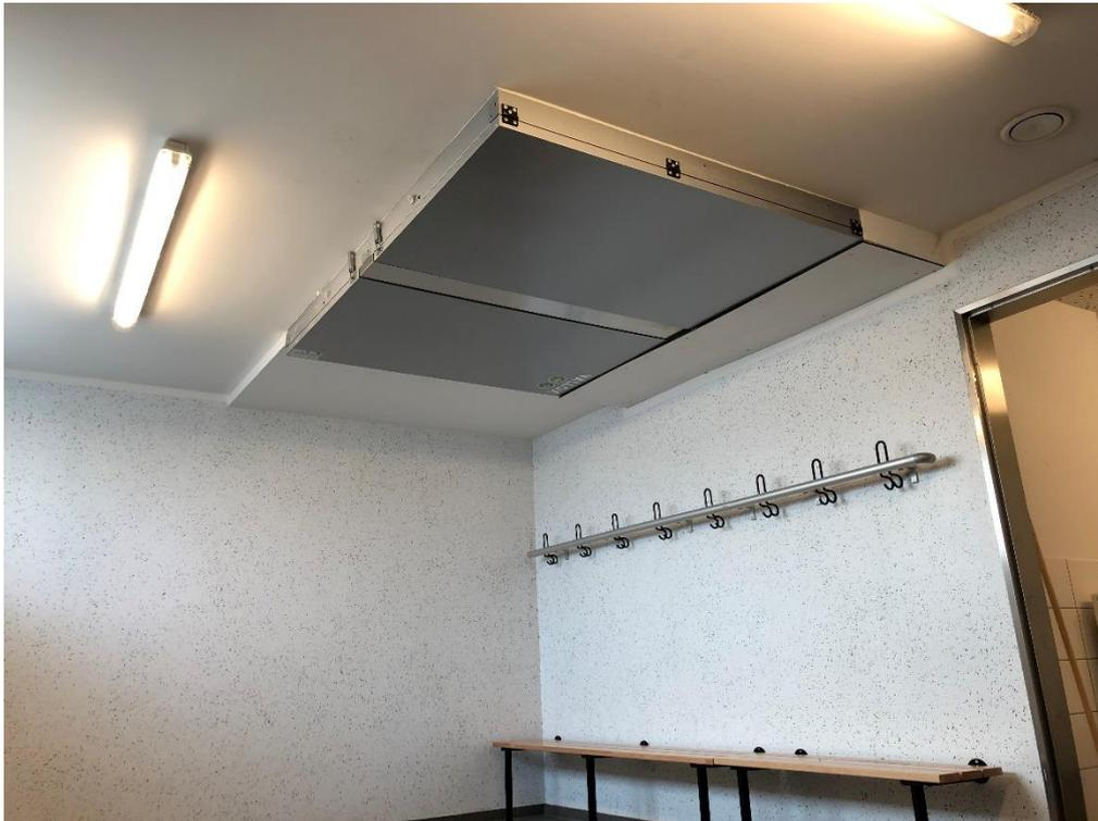
Das Gerät der RLT 3 für sämtliche 6 Umkleide / Duschbereiche sowie die öffentlichen WCs, das Foyer und den Sportwartraum ist mit 1.700 cbm/h Nennlüftung das größte Gerät. Aber es ist in der Decke der Umkleide 3 am unauffälligsten untergebracht. Es arbeitet u.a. feuchtegesteuert.
