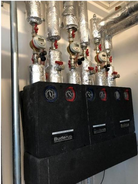
Oben: Der Heizungsverteiler für drei Bereiche, mit Wärmemengenzählern.
