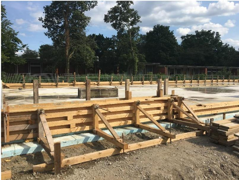
Die tragende Sohlplatte aus Stahlbeton liegt auf 24 cm Dämmstoff aus extrudiertem Polystyrol. Wegen der Barrierefreiheit in Verbindung mit dem Holzbau hat Architekt Heinicke ein neues, passivhaustaugliches Sockeldetail entwickelt, welches der DIN 68800-2 entspricht. Dieses wurde zwischenzeitlich auf mehreren Tagungen veröffentlicht, u.a. 2016 auf dem Internationalen Holz-Bau-Physik-Kongress in Leipzig durch den Kollegen und Sachverständigen Martin Mohrmann.
