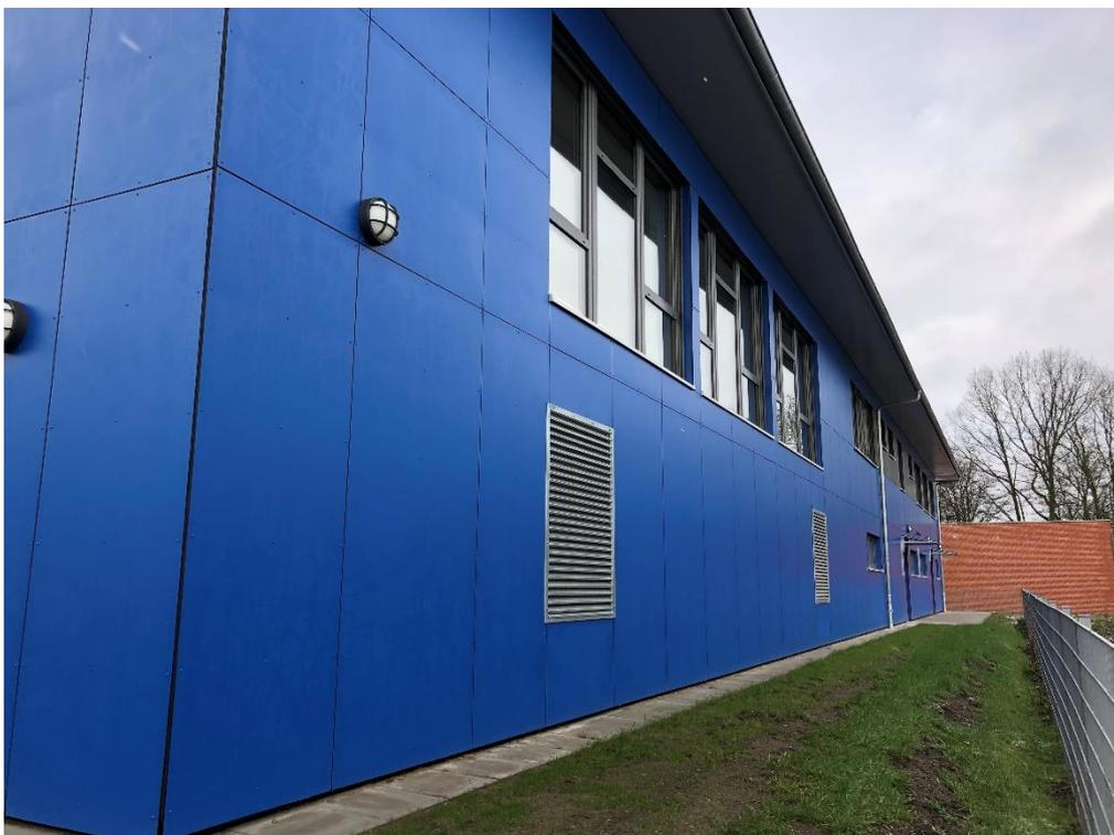
Ebenfalls Südostseite, im Vordergrund ist der Sportraum untergebracht. Dieser verfügt für die nächtliche Auskühlung über zwei Luftklappen, die sich hinter den Lüftungsgittern verbergen und die über die Gebäudeleittechnik gesteuert werden.
