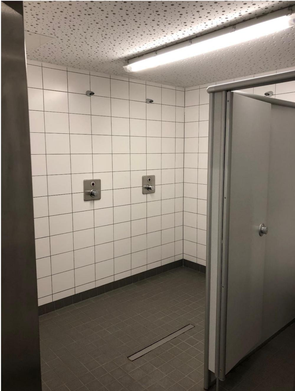
Duschbereich Nr. 5 mit WC-Kabine integriert. Alle Duscharmaturen haben eine selbstlernende, Spülautomatik für die Trinkwasserhygiene.
