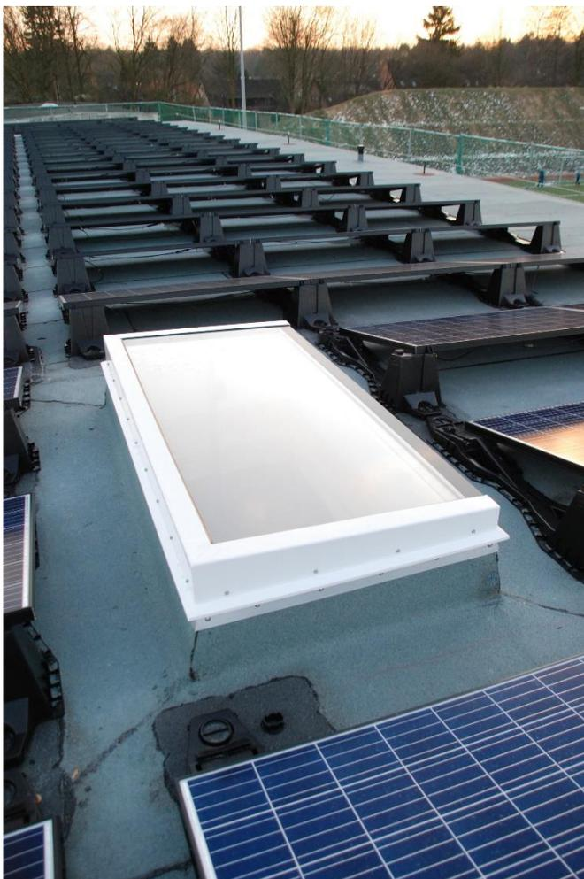
Die Befestigung der PV-Anlage erfolgte wärmebrückenfrei optimiert mittels Einkerbung mit Dachabdichtungsbahnen.
