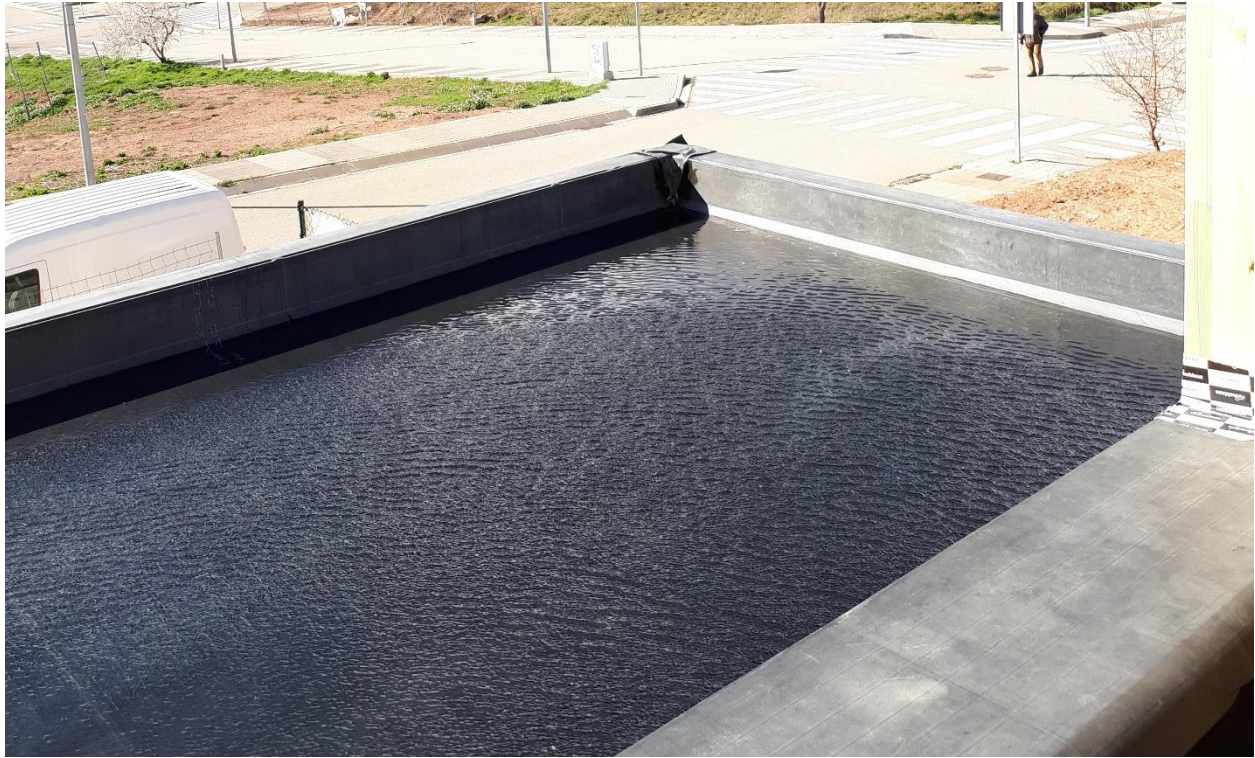
Fase de pruebas de estanqueidad al agua de la cubierta hecha en EPDM.
