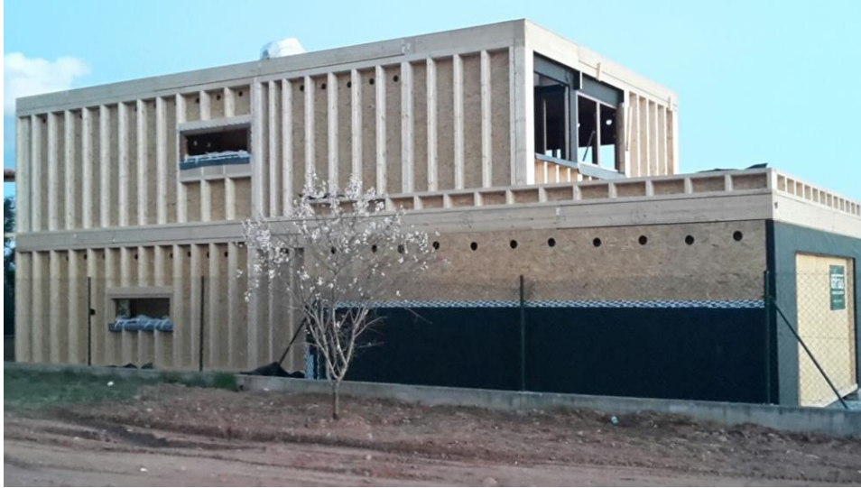
Montaje estructura madera - Vista fachada norte
