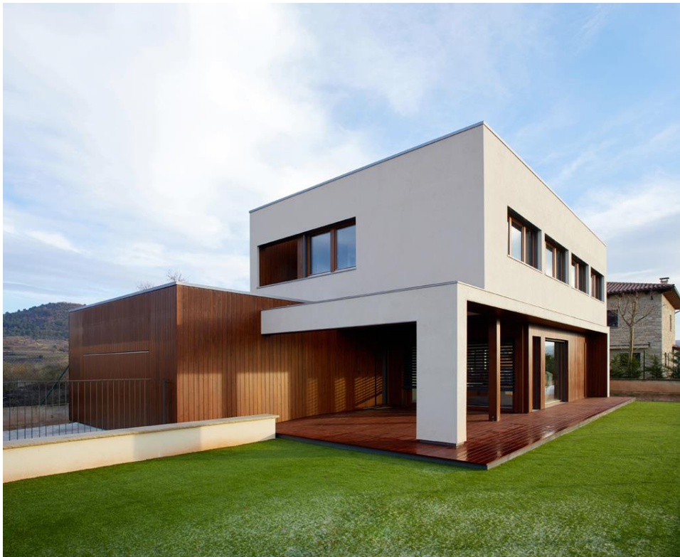
Vista fachada sur-oeste
