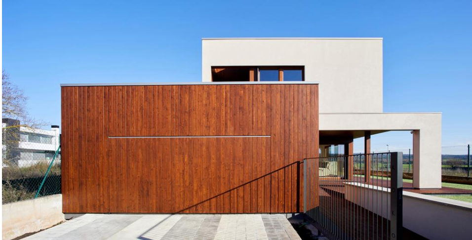
Vista fachada oeste- acceso garaje
