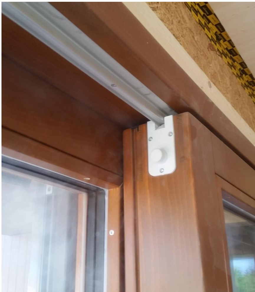
Puerta corredera con cerramiento estanco situada en la sala de estar.
