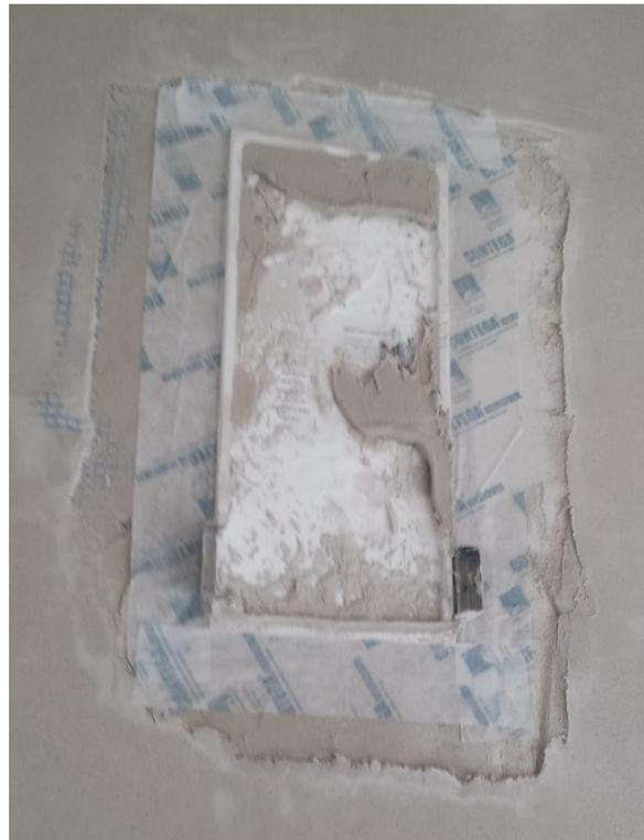
Luftdichter Anschluss Lüftungsgerät
