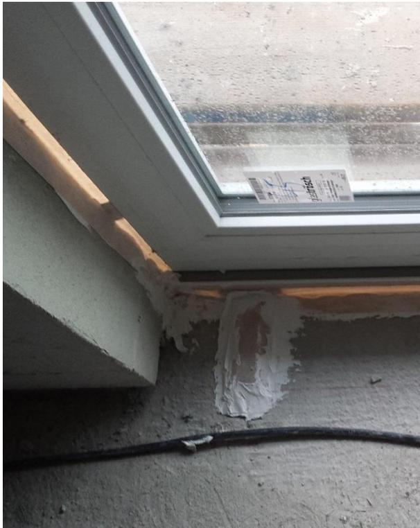
Luftdichter Anschluss Fenster
