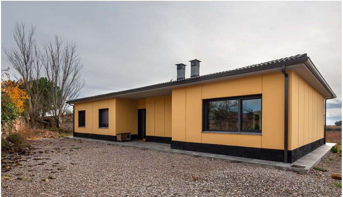
Source: Construcciones Zorzano
