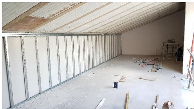
La composición de la cubierta del edificio se basa en la colocación de una capa de aislamiento de 16 cm de XPS sobre el forjado existente. Y realizando un trasdosado interior con PYL y aislamiento de 46 mm de lana mineral.
