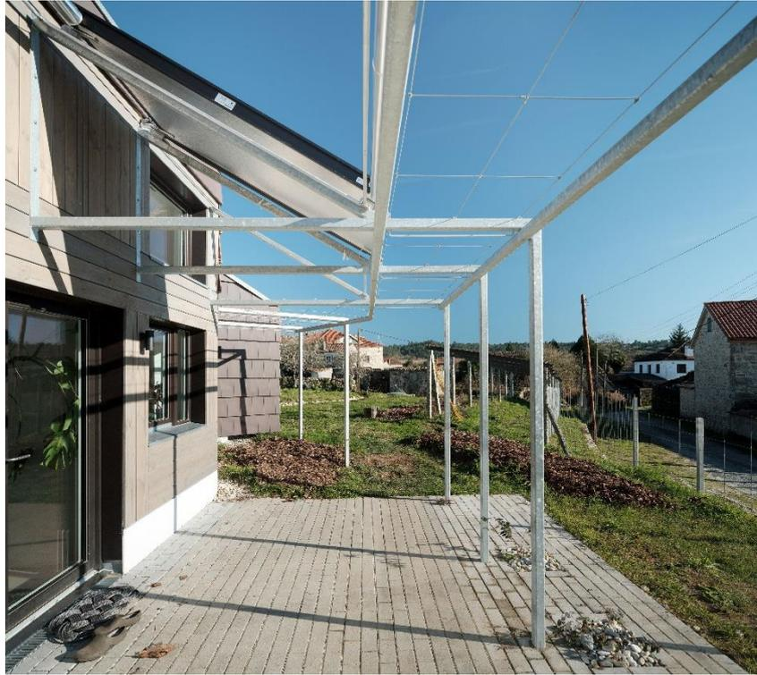
**Figura 5.** Detalle estructura para protección solar
