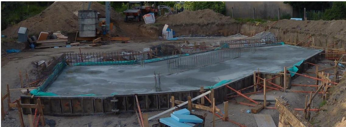
**Figura 23.** Proceso constructivo losa de cimentación
