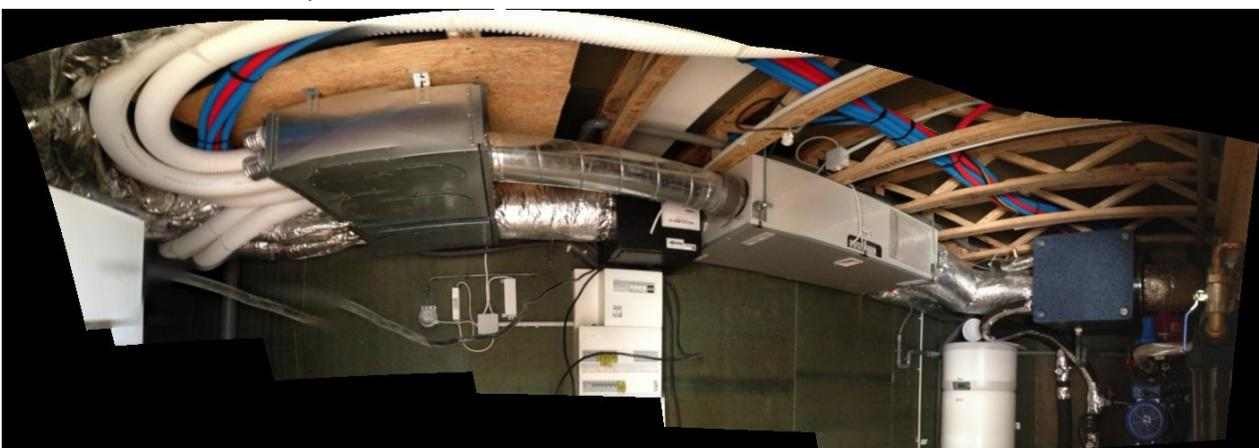
La centrale de ventilation mise en œuvre est une ComfoAir 200 de chez Zehnder, certifié PHI avec un rendement de récupération de chaleur de 92% et une consommation électrique de 0.42Wh/m3.
