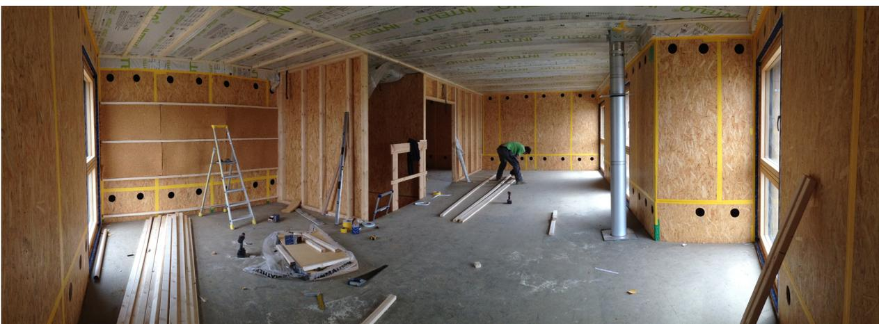
Le test de perméabilité du bâtiment est effectué sous dépression et en surpression de 50 Pa
