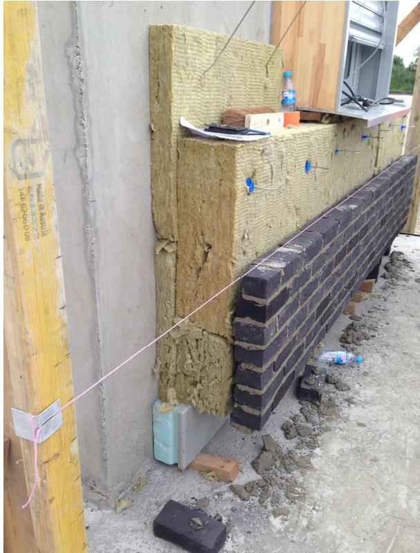
L'isolation est réalisée en double couche croisée de laine de roche (250 mm d'isolant)
