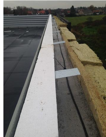
L'acrotère est complètement isolé (isolation sous couvertines / et côté intérieur de l'acrotère) Photos de l'acrotère avant implantation de l'isolant sous couvertines
