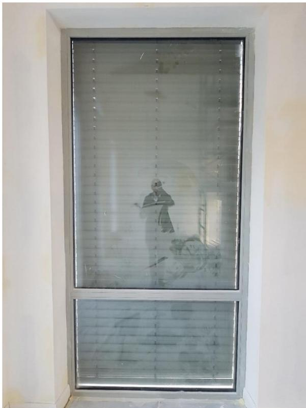
La mise en œuvre de chaque menuiserie a été conçue de manière à optimiser le pont thermique. Celles-ci ont été posées en applique contre la maçonnerie à l'intérieur d'un précadre bois construit préalablement à leur pose. Un isolant dans le doublage devant le frein-vapeur vient en recouvrement sur la menuiserie et permet de limiter le pont thermique de mise en œuvre.
