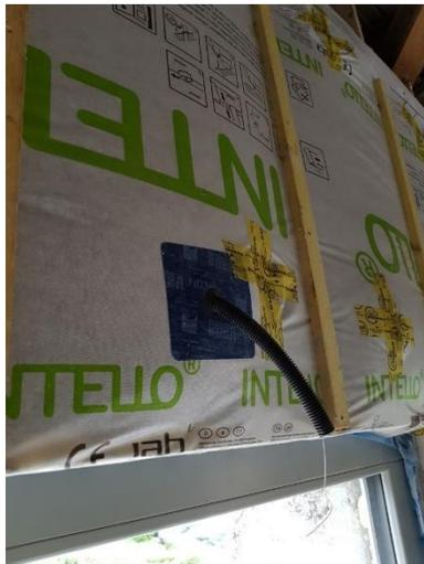
Chaque pénétration de gaines électriques et de ventilation vers l'extérieur a été identifiée au préalable et traitée avec les accessoires d'étanchéité adaptés de la marque PROCLIMA.
