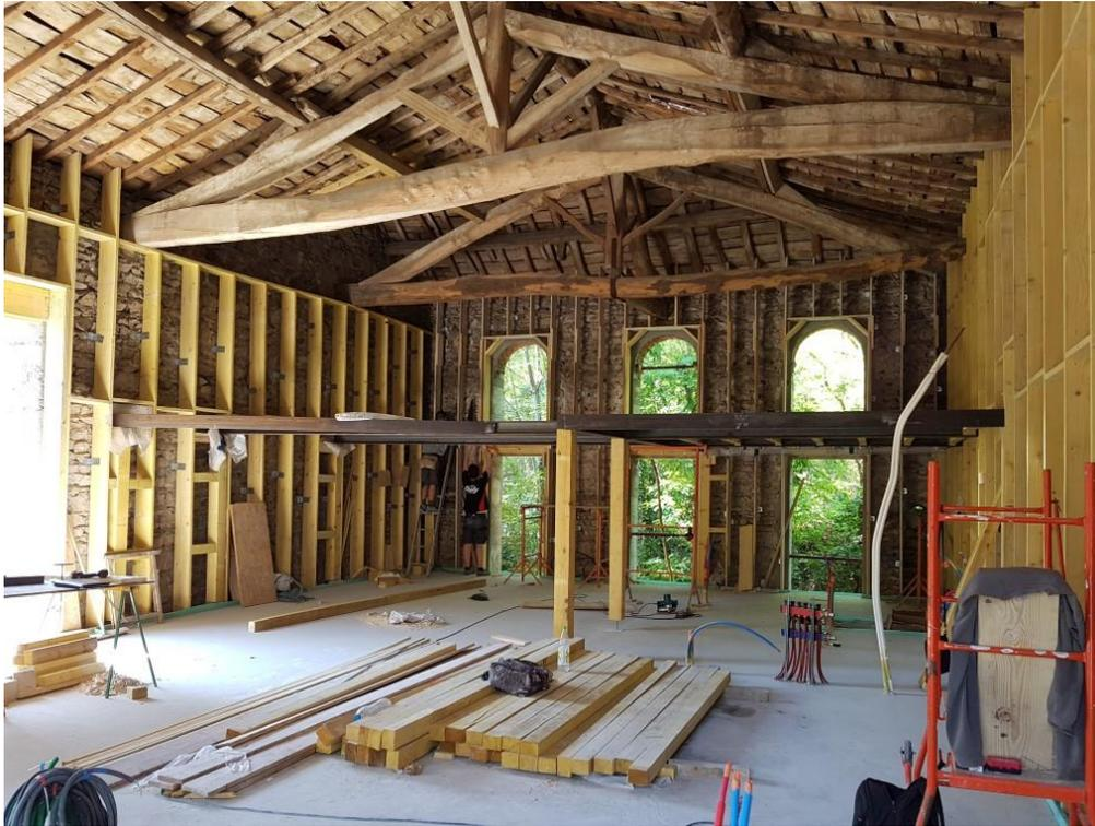
Aucun système industrialisé ne permettait d'isoler les murs par un doublage de 28 cm rempli de ouate de cellulose. Nous avons donc réalisé une ossature bois constituée de caissons permettant la fixation d'une membrane d'étanchéité à l'air et l'insufflation de ouate de cellulose.
