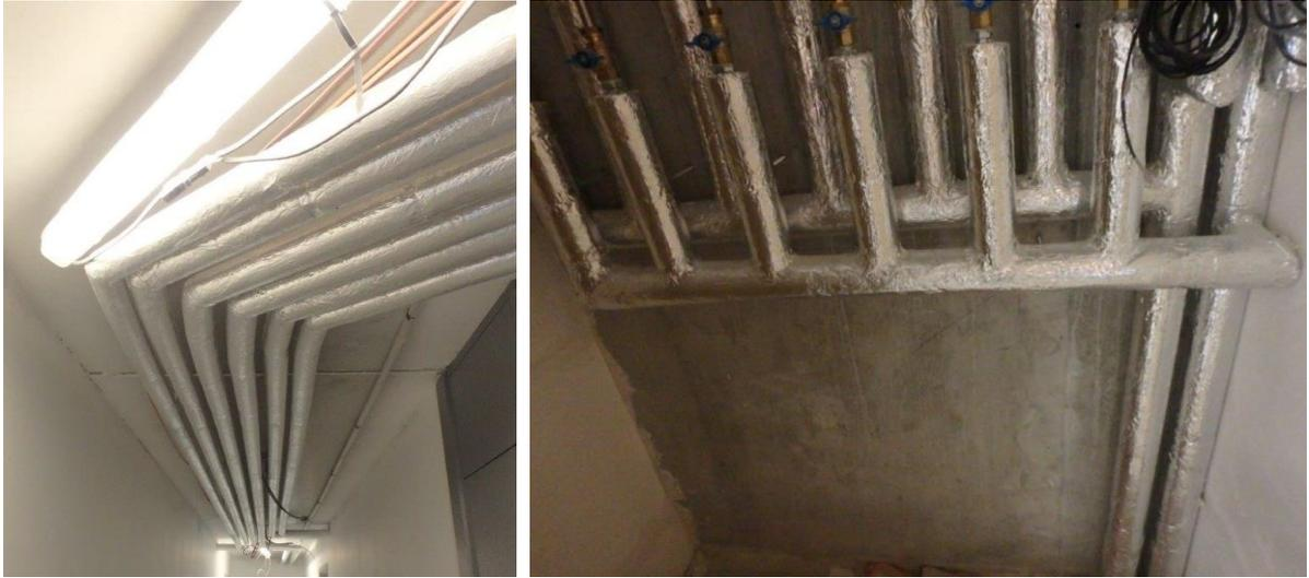
***Calorifugeage réseau de chauffage en gaine et faux plafond***
