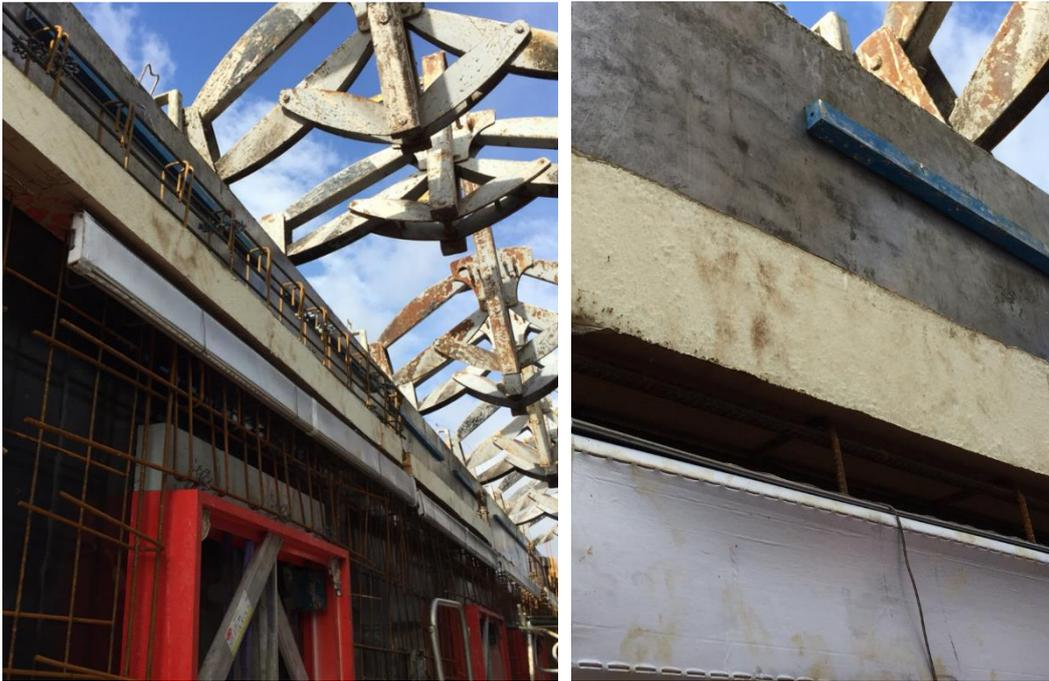
***Isolant des acrotères avant coulage béton***
