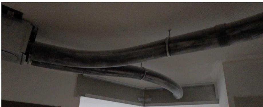
**Calorifugeage des gaines de soufflage terminal en semi rigide : Armaflex épaisseur 19 mm**
