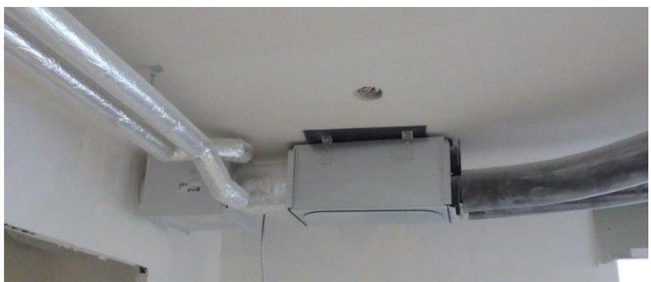
**Isolation en climaver 202 épaisseur 50 mm / Isolant Climaver 202 épaisseur 25 mm**
