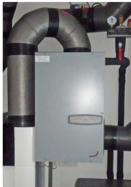
L'air frais de la maison est capté en façade est, vers l'unité de ventilation, et en zone isolée. Le réseau de ventilation est couplé à un échangeur géothermique eau/air Zehnder ComfoFond-L Q récupérant les calories contenues dans le sol grâce au fluide caloporteur, et ayant pour fonction le préchauffage et le rafraîchissement. La distribution se fait par le biais de tubes ComfoPipe 160. L'ensemble des machines se situe dans une pièce technique dédiée.
