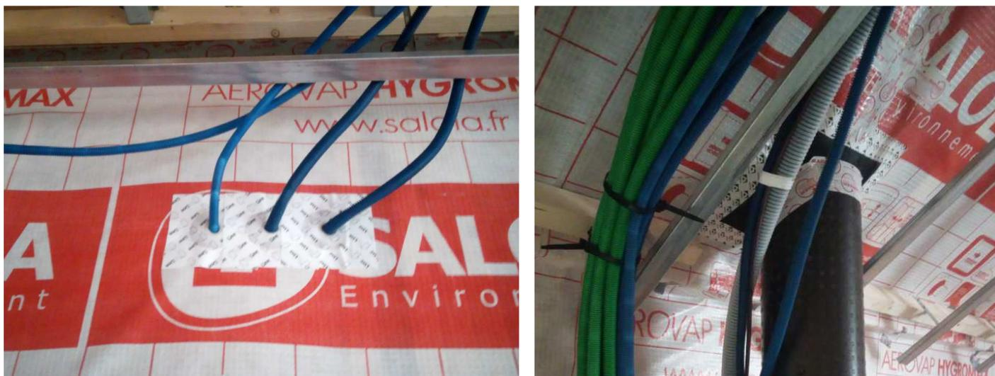
L'ensemble du réseau électrique comme celui de la ventilation est positionné à l'intérieur de l'enveloppe isolée et étanche à l'air.
