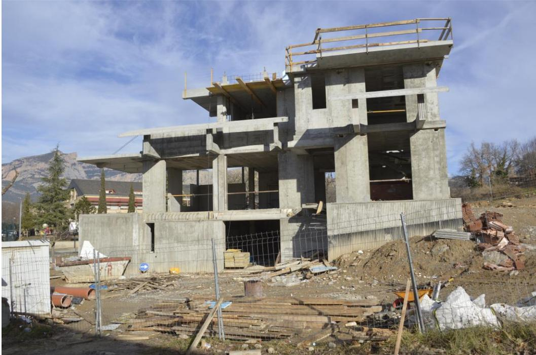
Estructura de muros de hormigón armado.
