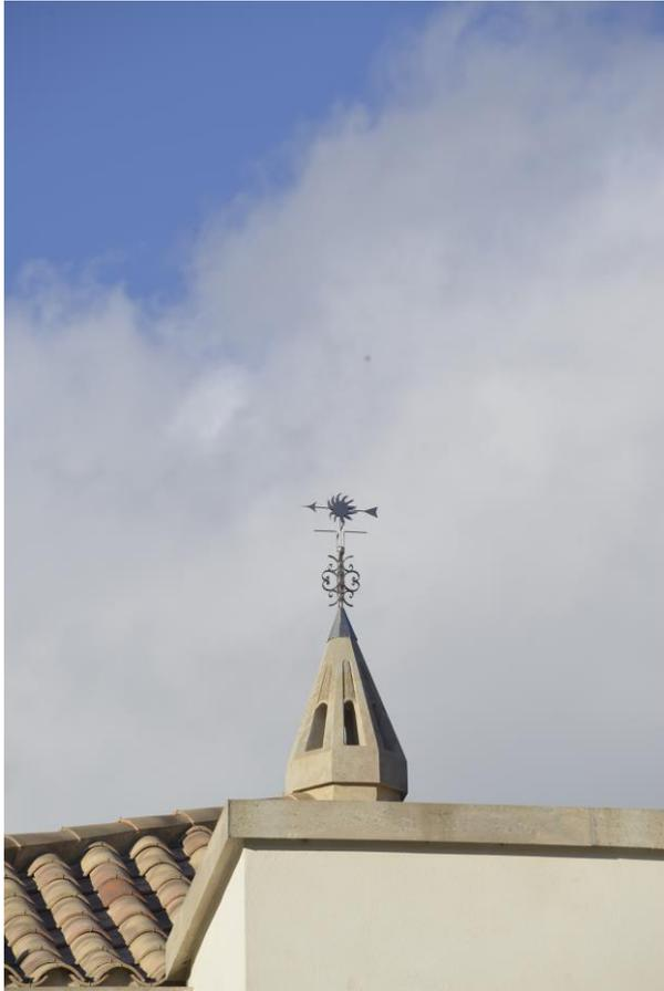
Imagen de la piedra octogonal superior de la cubierta con ocho aberturas para salida del aire caliente del espacio ventilado bajo cubierta.
