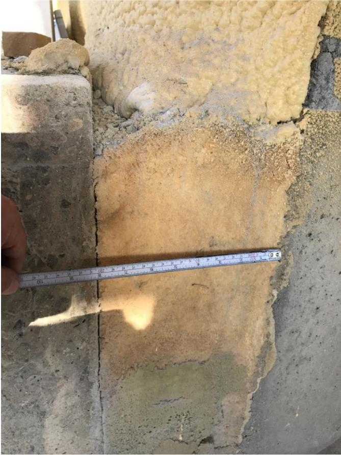
Hoja exterior del muro con bloques de hormigón celular de 20 cm de espesor y  $\lambda$  aproximada de 0.10 w/(mk).
