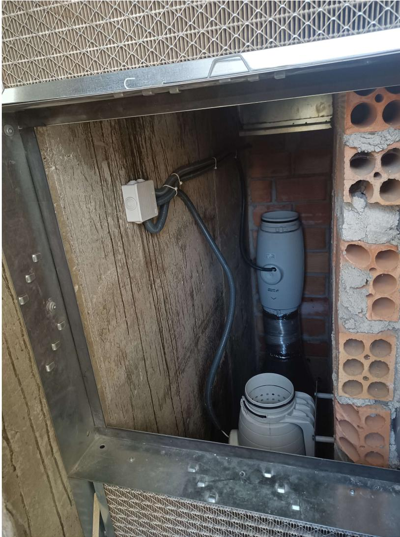
Imagen de los ventiladores el de la ventilación planta baja de consumo 99 w a máxima potencia y el de la ventilación planta 1ª de consumo 39w a máxima potencia..
