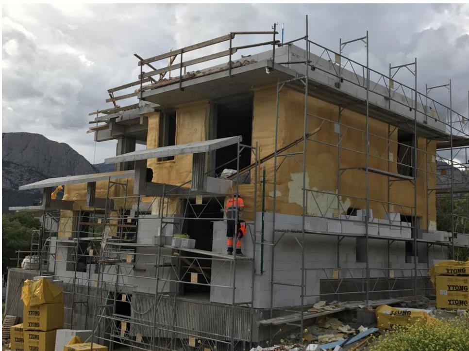
**U muros exteriores de la envolvente térmica  $U = 0.125 \text{ W}/(\text{m}^2\text{K})$ .**
