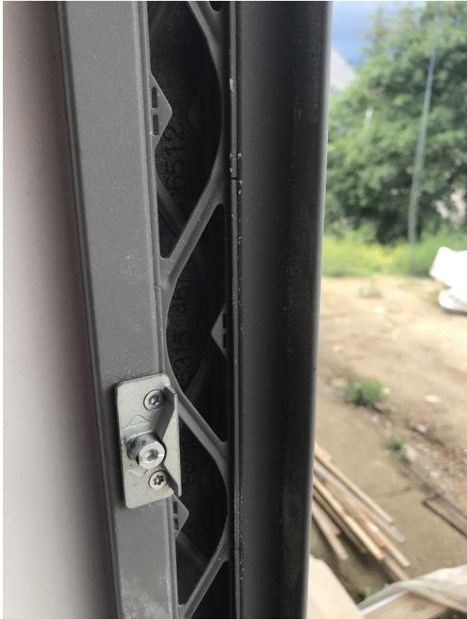
En la imagen se puede ver la rotura del puente térmico.
