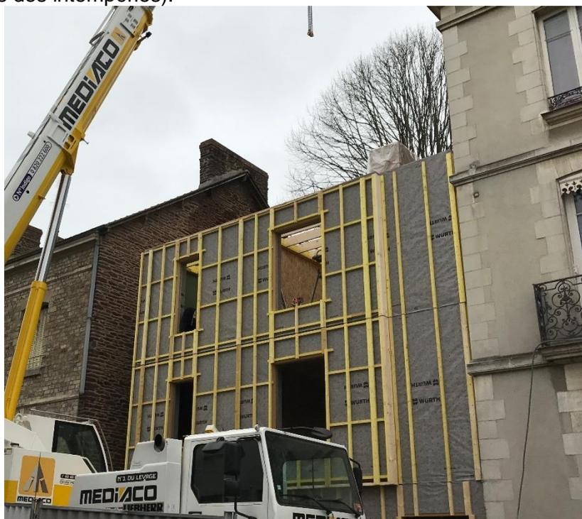
20 : Dépose des MOB niveau après niveau pendant le chantier. La fibre de bois n'est pas encore mise en œuvre.
