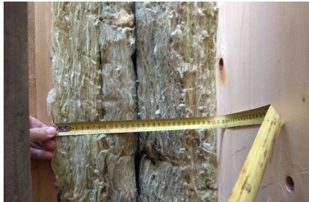
Espesor aislamiento en medianera 15cm
