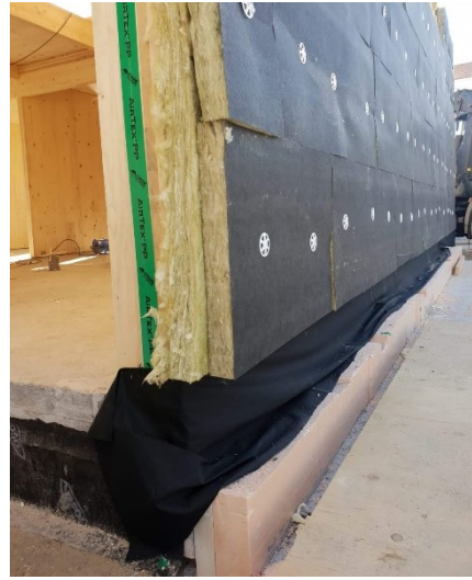
Espesor aislamiento en medianera 15cm
