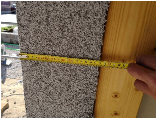
Espesor aislamiento de fachada 18cm
