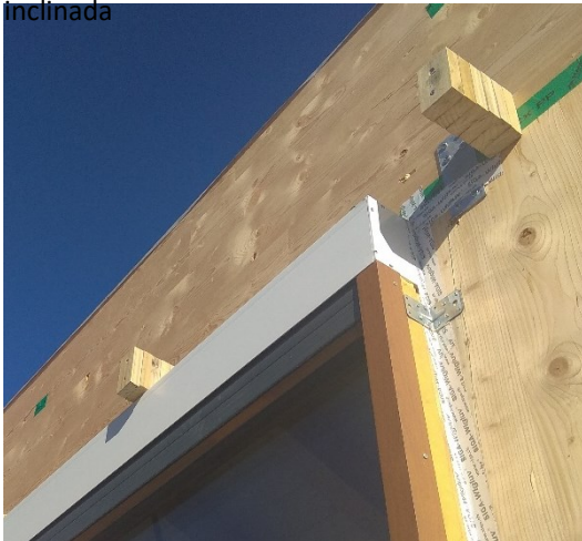
Hermeticidad de ventanas con banda de 90mm Inclinada
