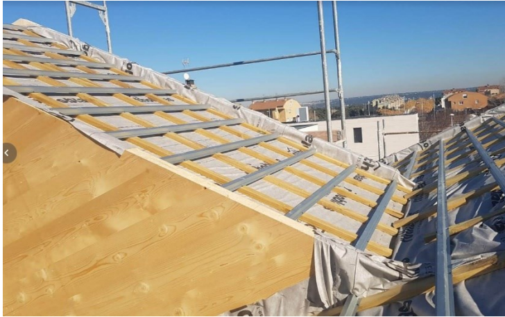
Colocación de lámina transpirable cubierta:
