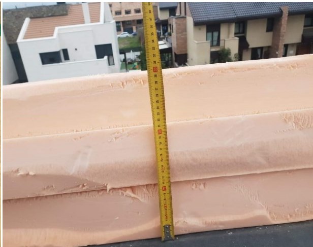
Espesor de aislamiento de cubierta
