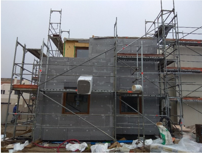
Aislamiento de fachadas por el exterior
