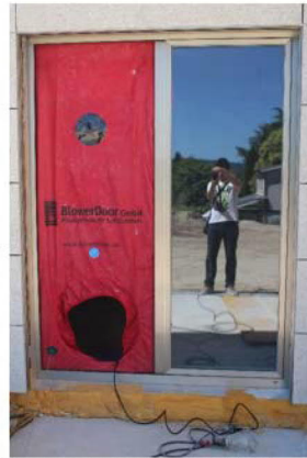
LONA Y PREMARCO INSTALADO
