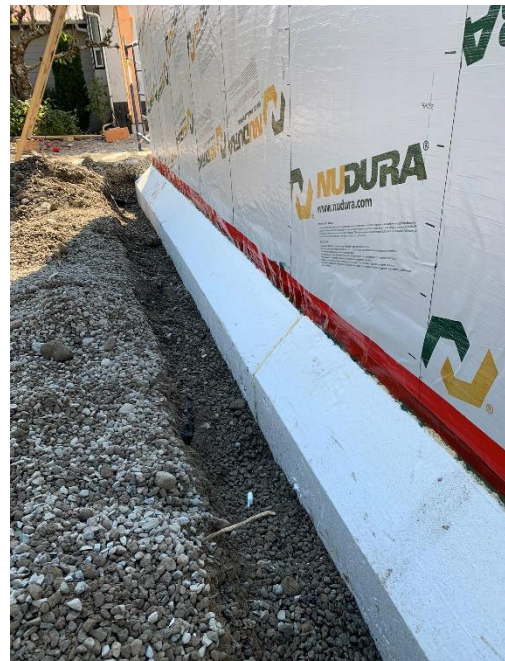
Slab edge insulation
