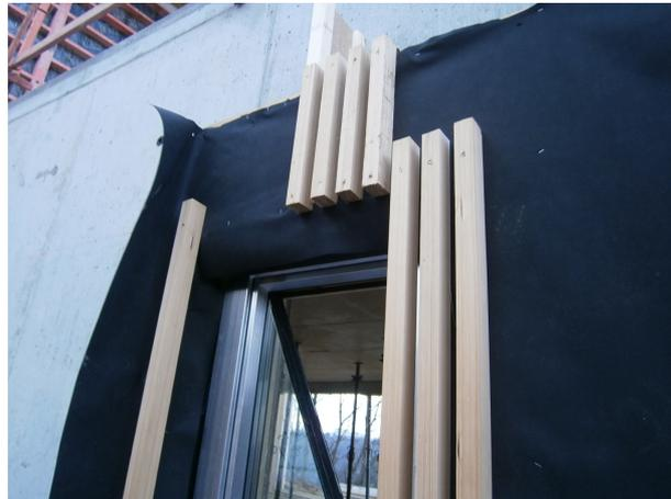
Le rendu recherché d'un alignement des tasseaux de bardage avec les encadrements de fenêtre et une excellente gestion des ponts thermiques de mise en œuvre est obtenue :
