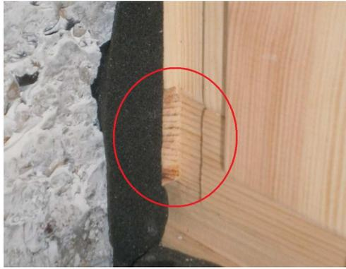
Une fois le prototype de fenêtre validé, le façadier a réalisé un prototype de bardage pour que l'on réduise les ponts thermiques de mise en œuvre.
