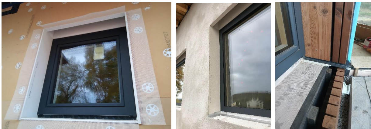
12. Recercado exterior de ventanas con sistema Implio de Gutex y cajón para recibir la protección solar Griesser
