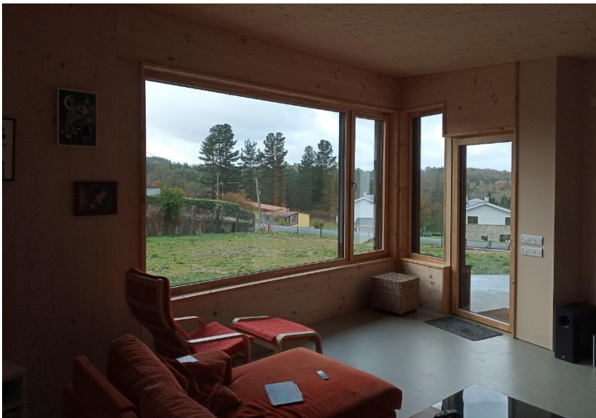
5. Vista interior desde el salón. El CLT se deja visto por el interior en determinados paños.
