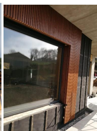
18. Elementos de hermeticidad en base de muros, juntas y fachada ventilada.
