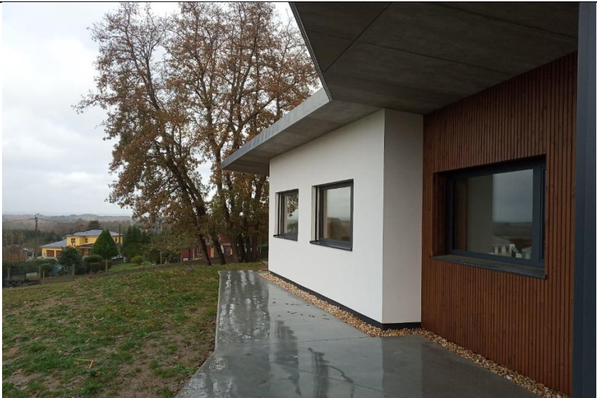
3. Detalle del alzado suroeste desde el porche. Se observa el revestimiento inferior del alero con panel Viroc de fibra de madera y cemento.
