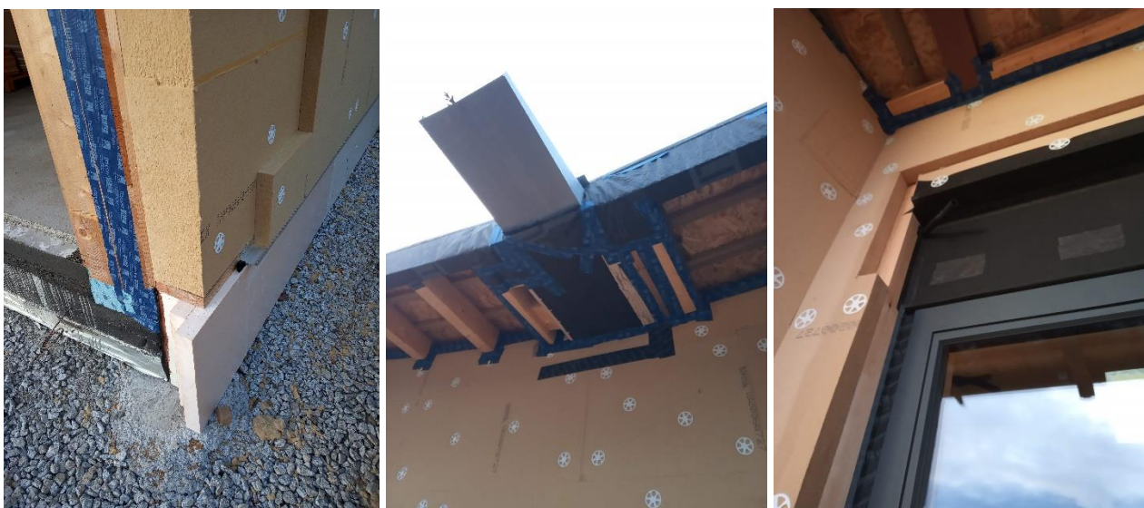
8. Colocación del aislamiento de fibra de madera en base de muros, encuentro con alero y con ventanas
