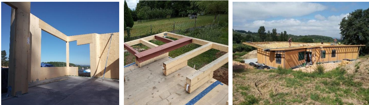
7. Montaje de la estructura de madera contralaminada CLT y los elementos estructurales de los voladizos
