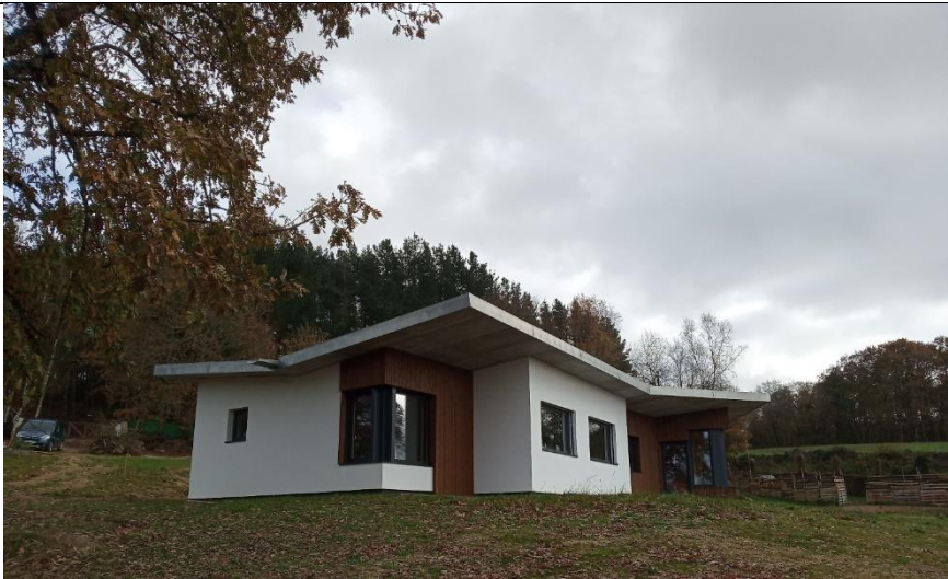
2. Vista de alzado noroeste y suroeste. Esquina del dormitorio principal. Se observa la forma de la cubierta a 2 aguas en V con salida libre del canalón, evitando elementos de evacuación de agua de cubierta en todo el frente suroeste.
