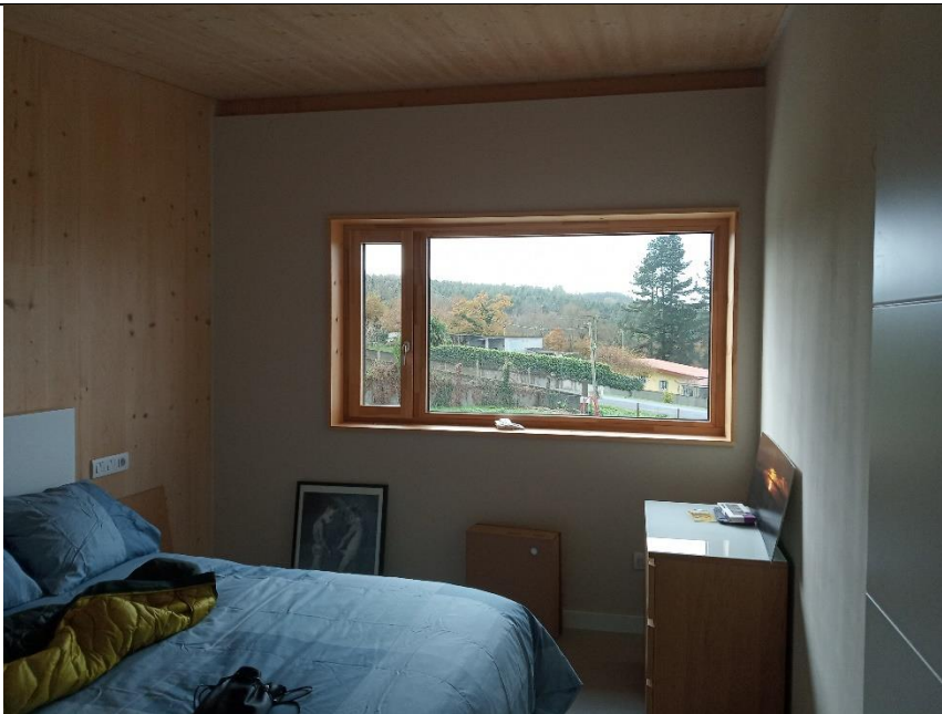
8. Vista interior de un dormitorio. Determinados paños se cubren con trasdosado de pladur, para albergar las instalaciones.
