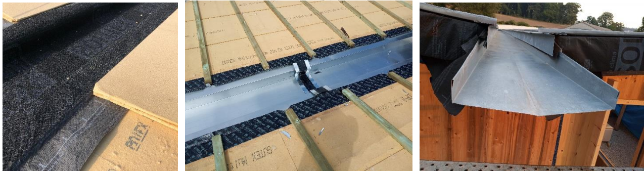
19. Elementos de hermeticidad en cubierta bajo la lámina de cinc.
