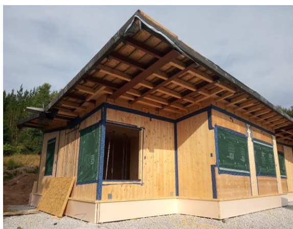
18. Elementos de hermeticidad en base de muros, juntas y fachada ventilada.
