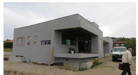
Se coloca un sistema SATE con paneles aislantes de espuma rígida de poliestireno expandido de 12 cm fijados con adhesivo y espigas en la zona de la paca base.
