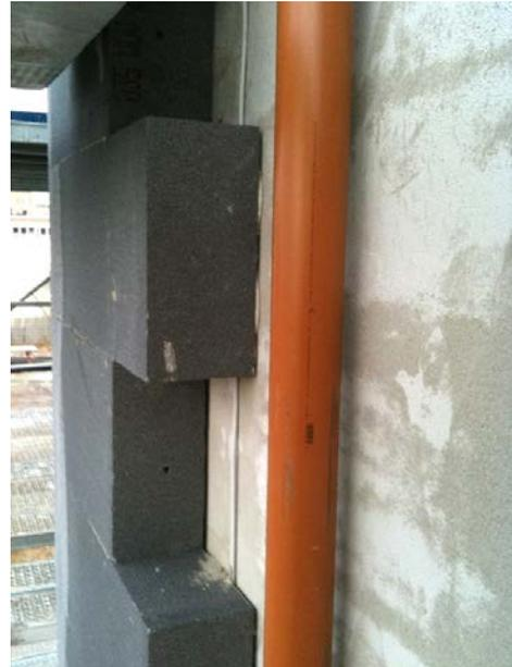
Bei der aus Betonplatten bestehenden Bestandswand wurden die Plattenstöße auf der Außenseite geschlossen, um die Luftdichtheit der Wandbauteile zu gewährleisten. Auf der Bestandswand wurde dann außen ein Wärmedämmverbundsystem (EPS 035) mit einer Dämmstärke von 260 mm aufgebracht.
