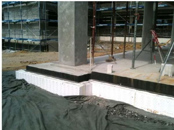
Um die konstruktiv bedingte Wärmebrücke gering zu halten, wird im Sockelbereich eine Perimeterdämmung XPS (Dicke 200 mm) sowie eine waagerechte Dämmschürze aus Schaumglasschötter (Höhe im Mittel 220 mm) eingebaut.
