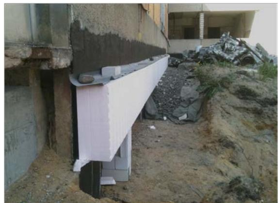
Der Fußboden im Zwischenbau / Eingangshalle wird neu aufgebaut und erhält unter der Bodenplatte eine Dämmschicht aus Schaumglasschotter. Um die konstruktiv bedingte Wärmebrücke zu reduzieren, wird im Sockelbereich zusätzlich eine waagerechte Dämmschürze aus Schaumglasschotter eingebaut.
