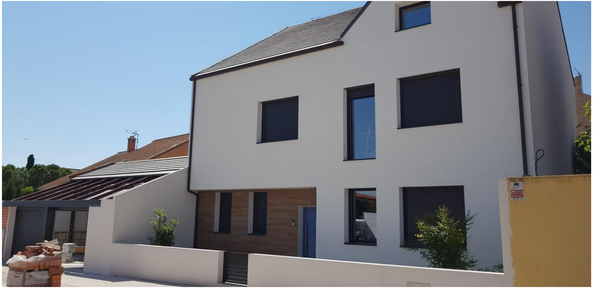
Fachada Norte delantera
