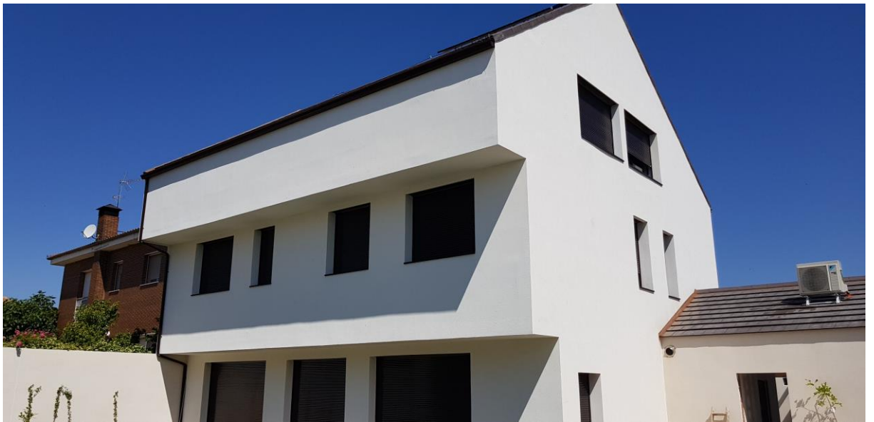
Fachada Sur trasera
