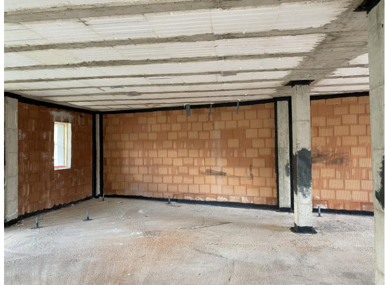
Tratamiento hermeticidad en pilares, forjados y techos
