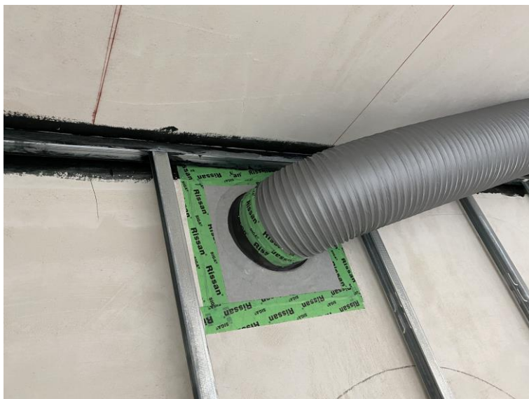
Tratamiento de perforaciones en lámina hermética
