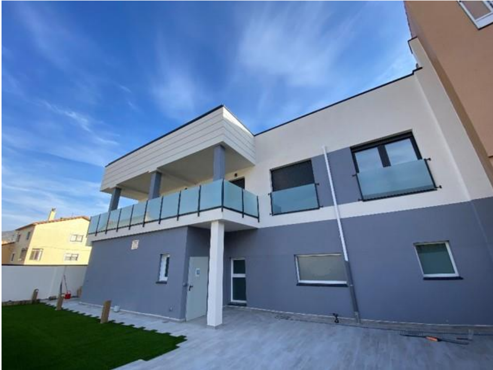
Fachada Oeste ( Fuente: José Luis Calles Calles )
