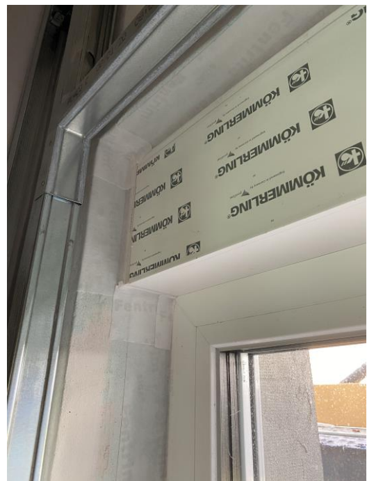
Colocación cintas herméticas en carpintería
