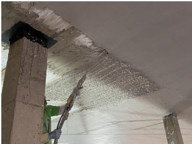
Aplicación lámina hermética con yeso proyectado
