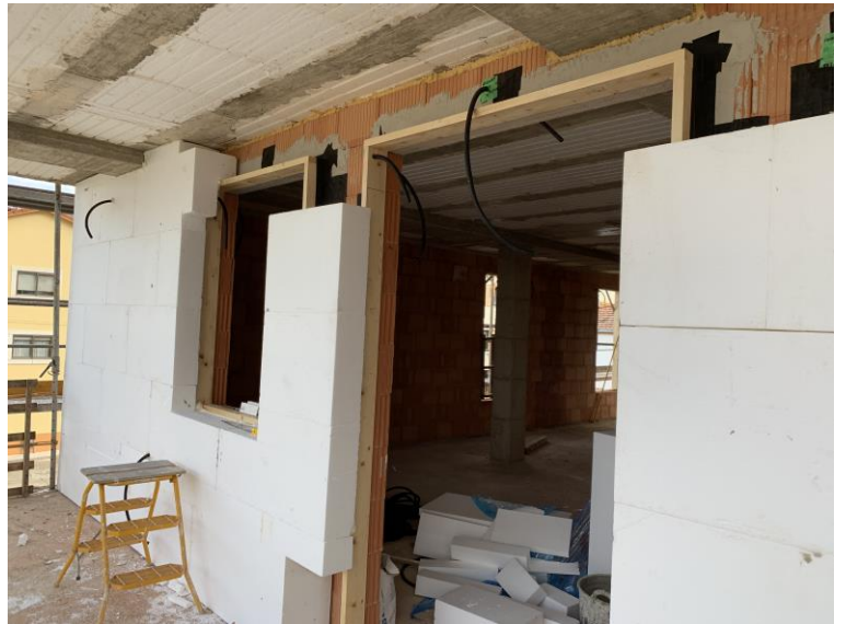
Instalación de SATE
