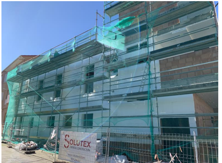
Instalación de SATE
