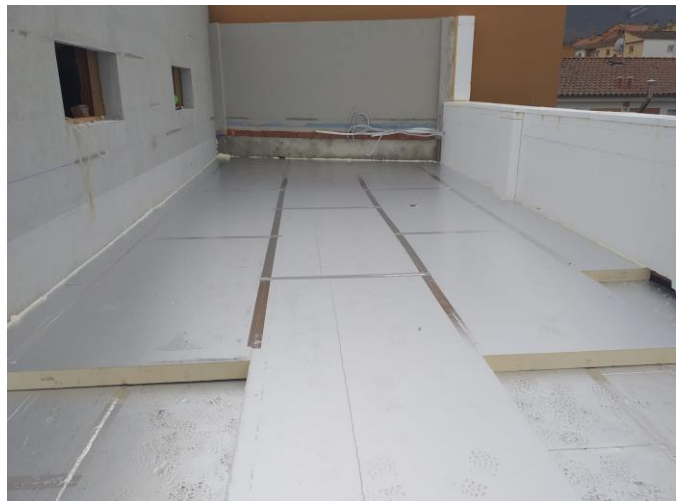
Colocación aislamiento PIR en cubierta
