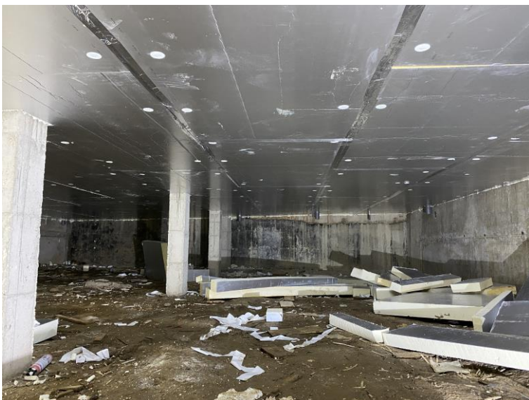
Colocación aislamiento PIR en forjado sanitaria:
