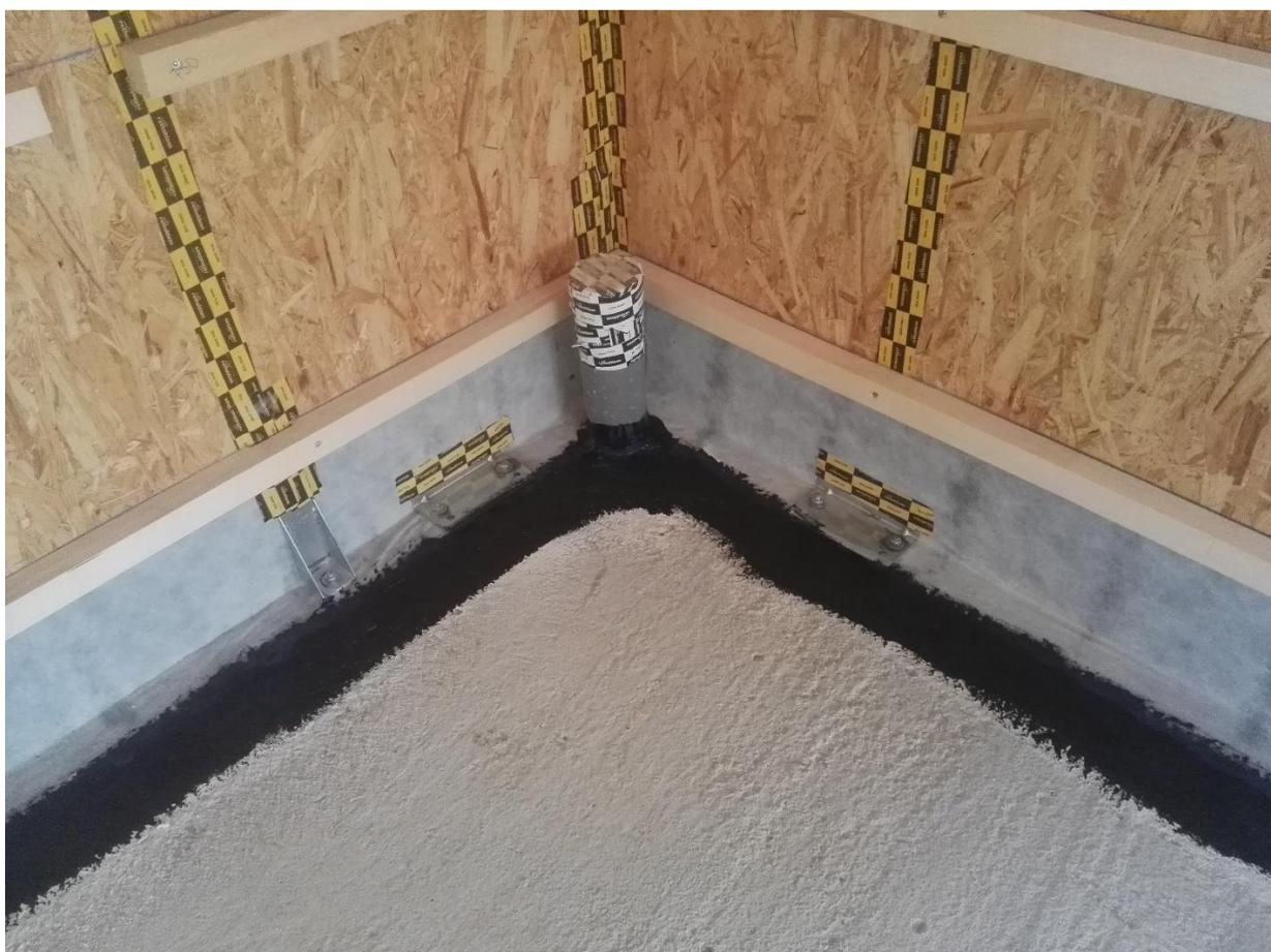
Se fijan los módulos a la solera de la Planta Baja, además de rellenar el hueco entre módulo y solera, aplicar lámina y posterior sellado blowerproof (en todo el perímetro de la envolvente térmica y hermética).
