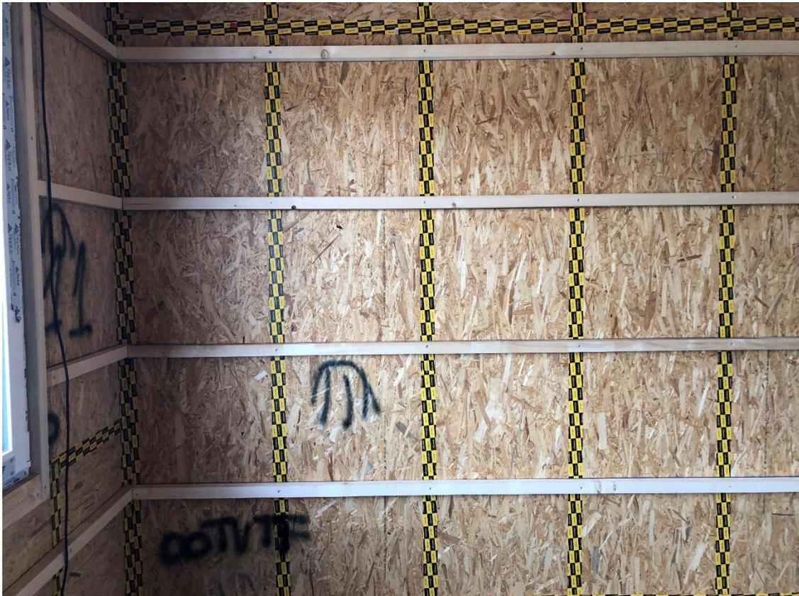
**Imagen de trasdosado interior con los rastreles en posición horizontal (con aislamiento)**
