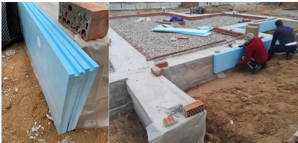
Por el lado exterior, se une la envolvente térmica ya ejecutadas (el aislamiento del módulo de madera con el aislamiento de la cimentación), con una plancha de XPS.
