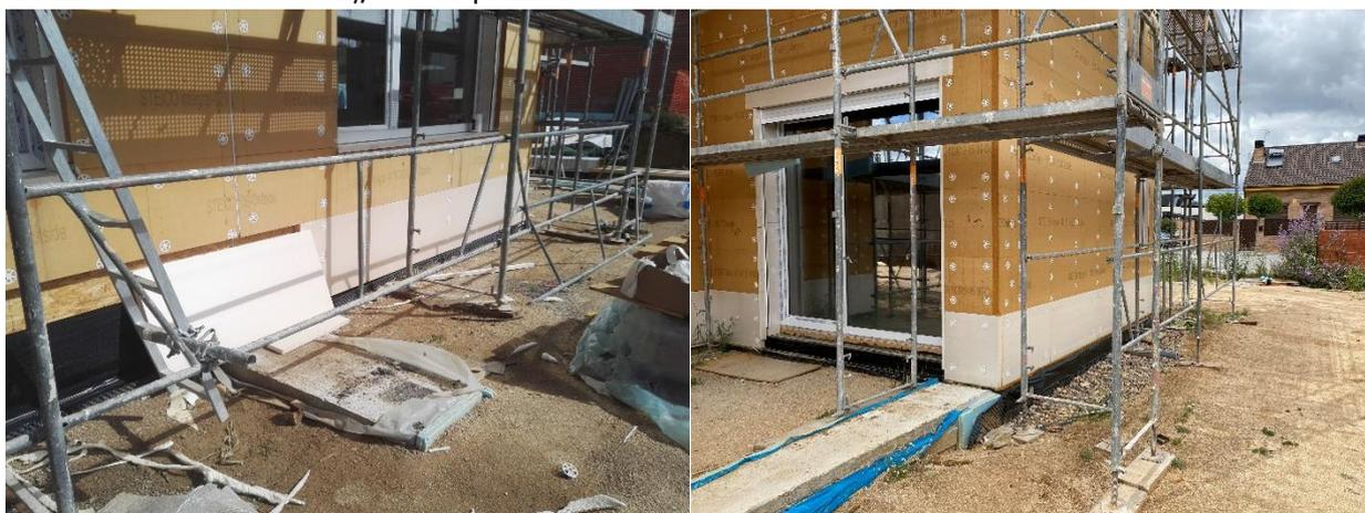
A continuación, por el lado interior, se coloca el XPS del suelo para crear la envolvente térmica.
