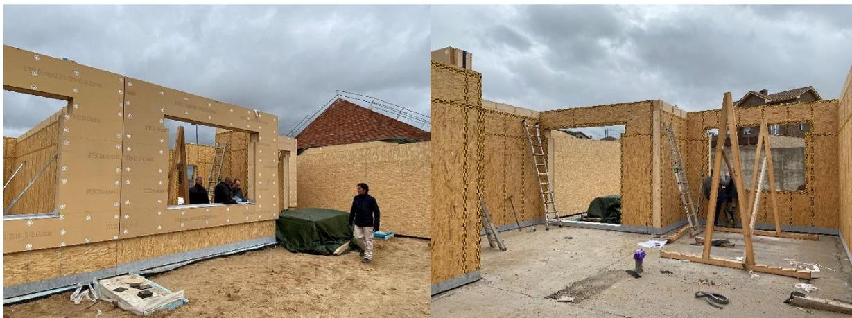
Posteriormente, se colocan los módulos de madera, anclándolos temporalmente hasta tener toda la estructura montada completamente, con sus vigas y pilares de apoyo anclados.
