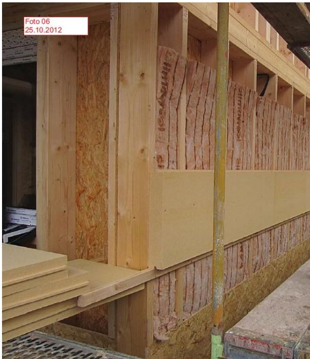
Bild: Der Aufbau der Außenwand: außenseitiger Aufbau mit 24 Dämmung zwischen Holzständern und 10cm Putzträgerplatte.
