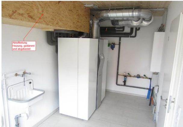
Bild: Innenaufnahme des Technikraum mit Kompaktlüftungsgerät. Die Fort- und Außenluftkanäle verlaufen in einer zusätzlich gedämmten Einhausung
