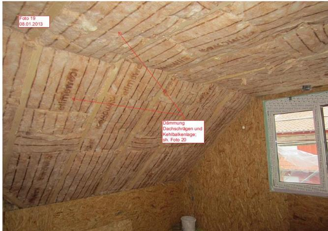
Bild: Innenansicht von Schrägdach und Kehlbalke mit 24 cm Dämmung.
