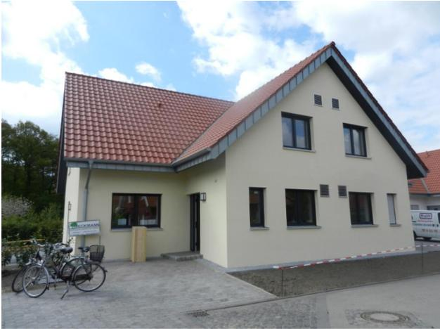
*Nordfassade mit Zugang zum Gebäude. Deutlich erkennbar sind die Zu- und Abluftöffnungen für das Kompaktlüftungsgerät*
