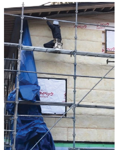
外付加断熱施工状況
