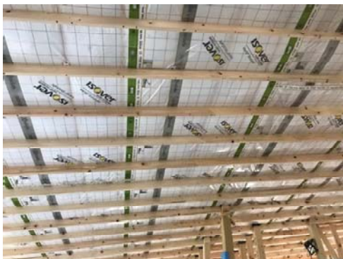
防湿シート施工
