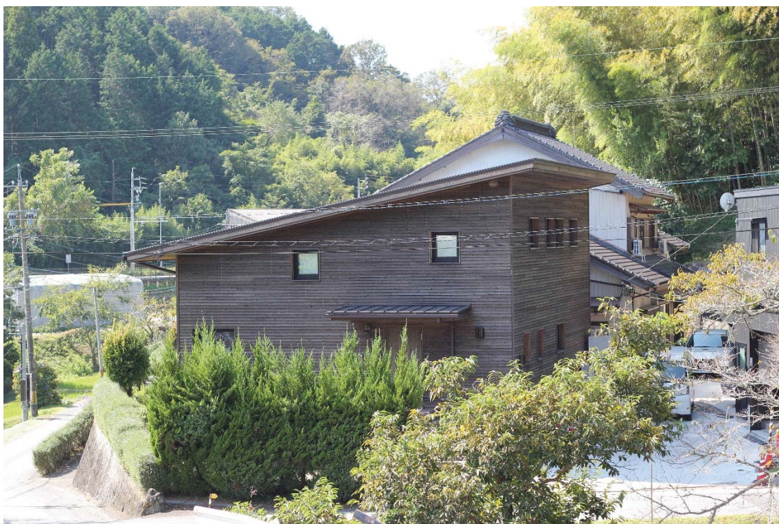
東からの眺め。奥に隣接する屋根と比べても低いプロポーションがわかります
