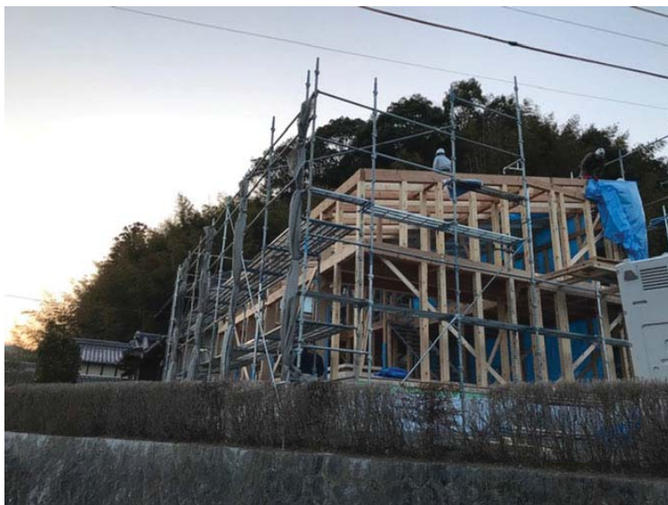
在来工法 上棟時の状況
