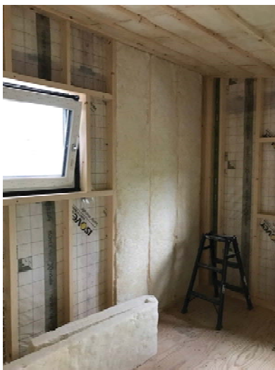
防湿シートと内付加断熱施工状況
