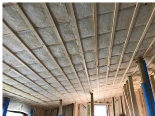
充填断熱状況
