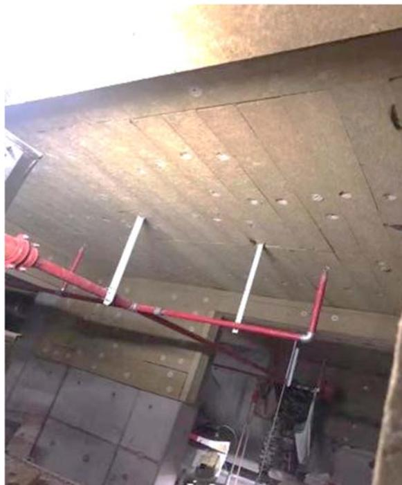
Unterhalb der Kellerdecke liegt Mineralwolle (60mm dick). Um die Wärmebrücke gering zu halten, wird die Dämmung über 1 m lang die Kellerwand entlang errichtet.
