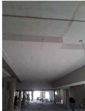
Die Decke über der Tiefgarage zum beheizten Erdgeschoss wurde von unten mit 20 cm Multipordämmplatten beklebt und gedübelt.
