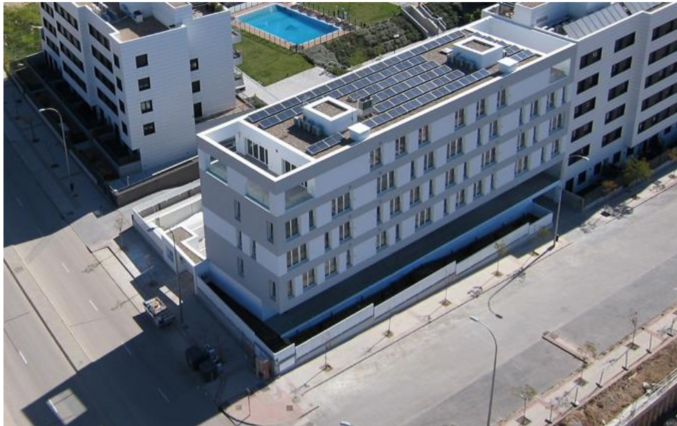
Vista exterior. Alzados noroeste y suroeste
