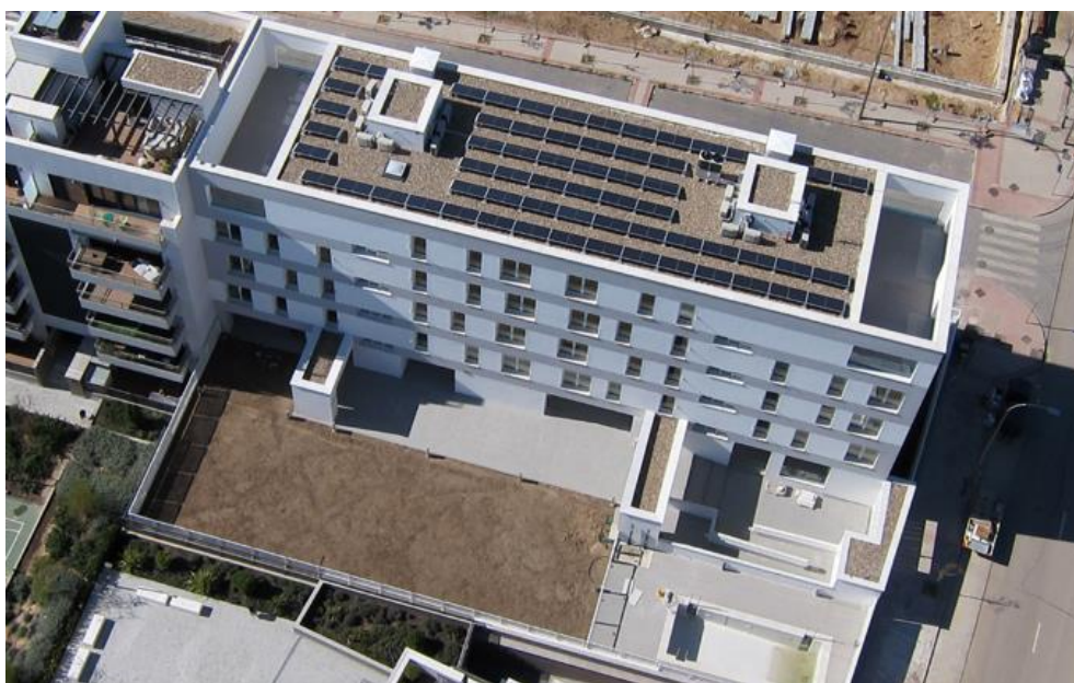
Vista exterior. Alzado sureste
