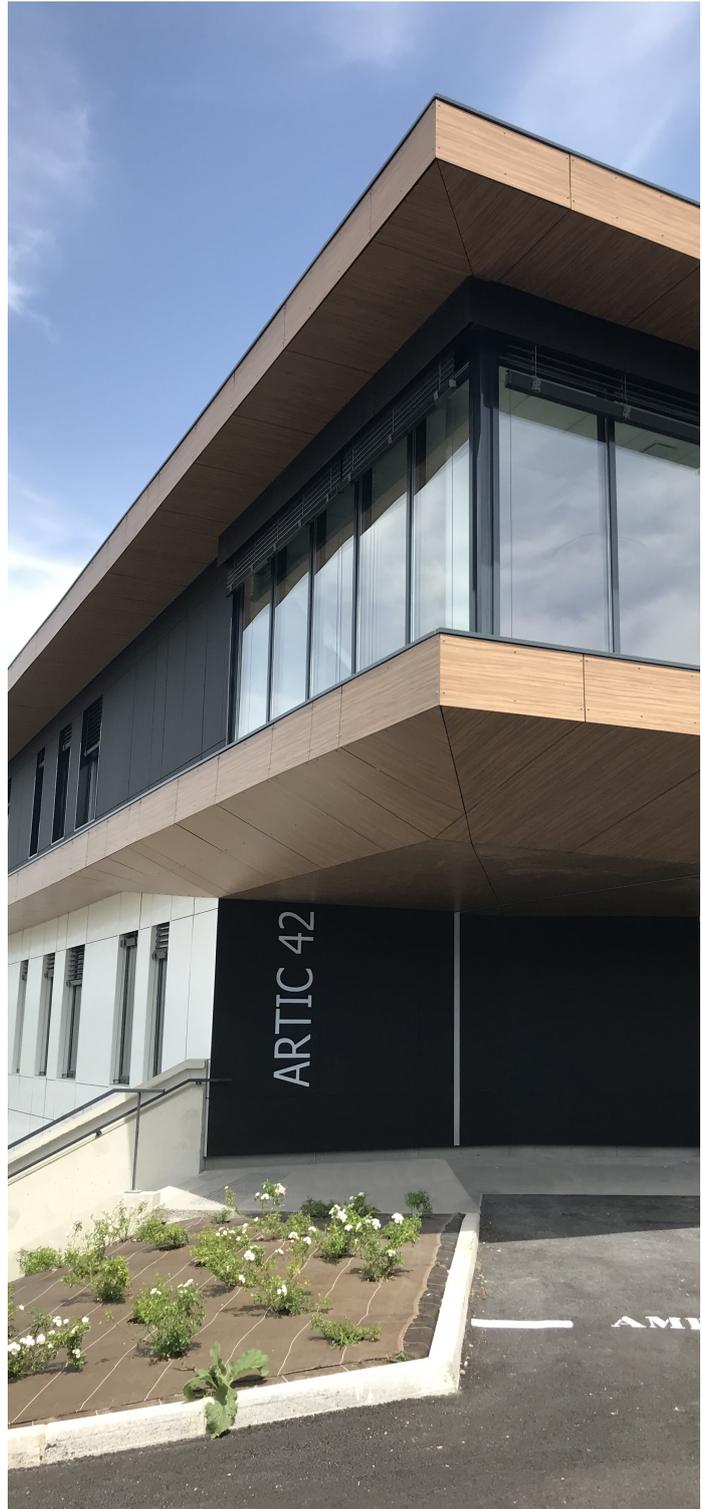
Les menuiseries sont en alu avec rupteur de pont thermique en triple vitrage sur l'ensemble des locaux. L'espaceur est en matériau composite, warm edge. Elles sont posées en applique extérieure, entre le cadre et le voile béton est posé un compriband, complété par une membrane d'étanchéité sur le pourtour.
