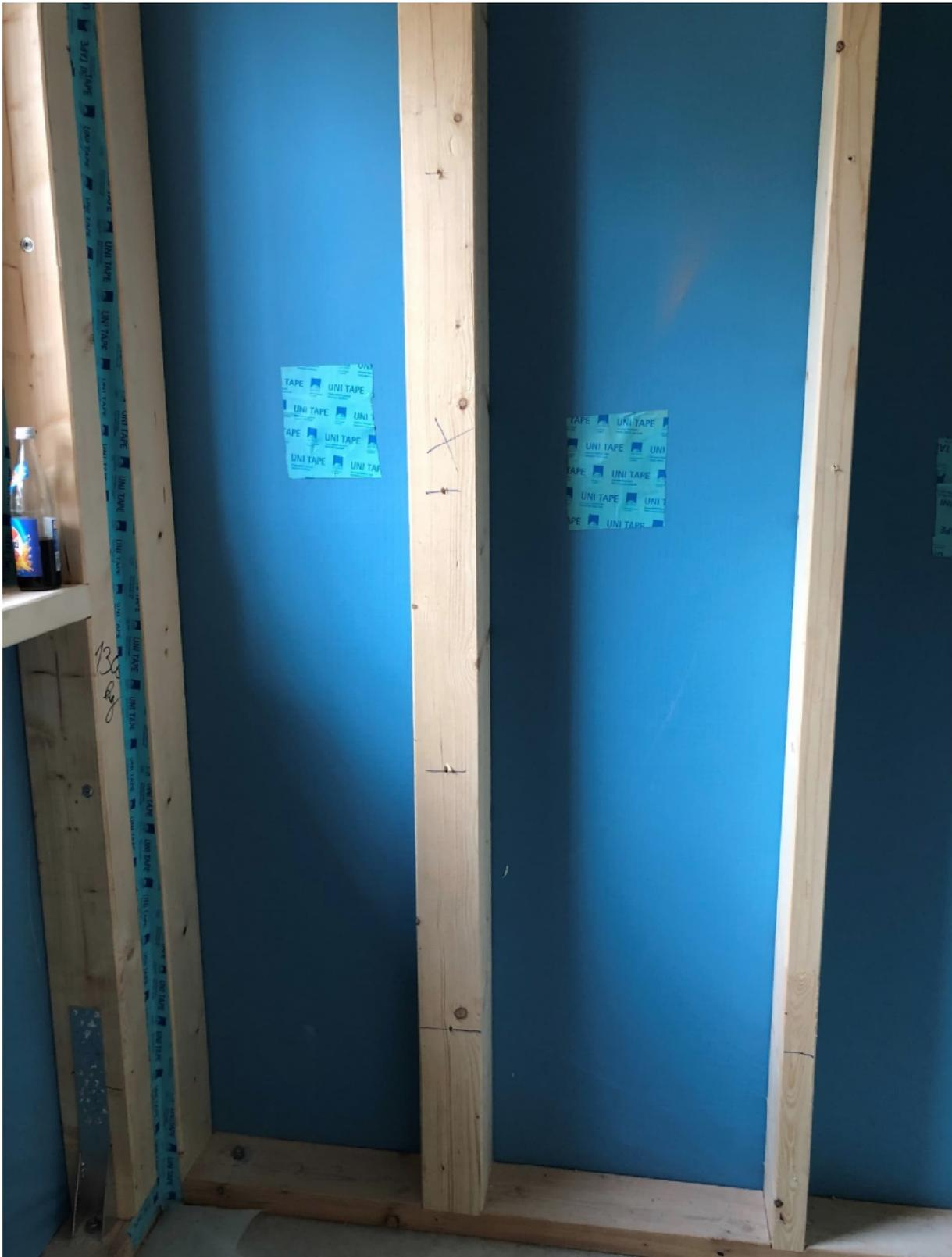
**Dampfdichtes Verschließen der Einblaslöcher durch Abkleben**
