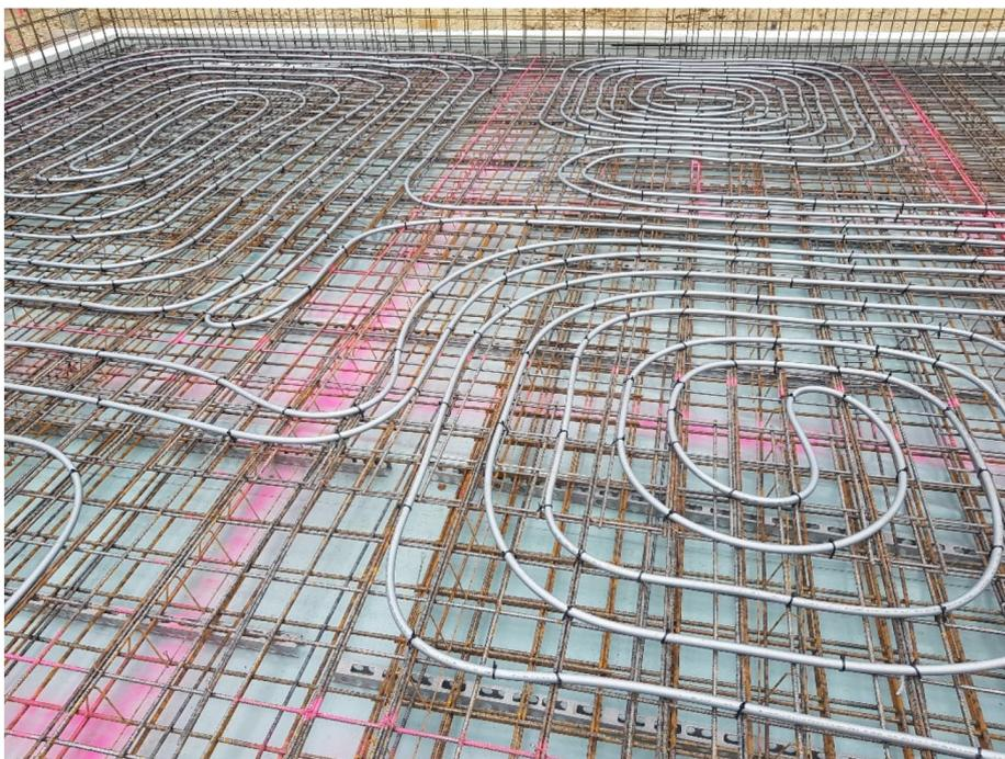
**Bodenplatte Bewehrung und Fußbodenheizung**
