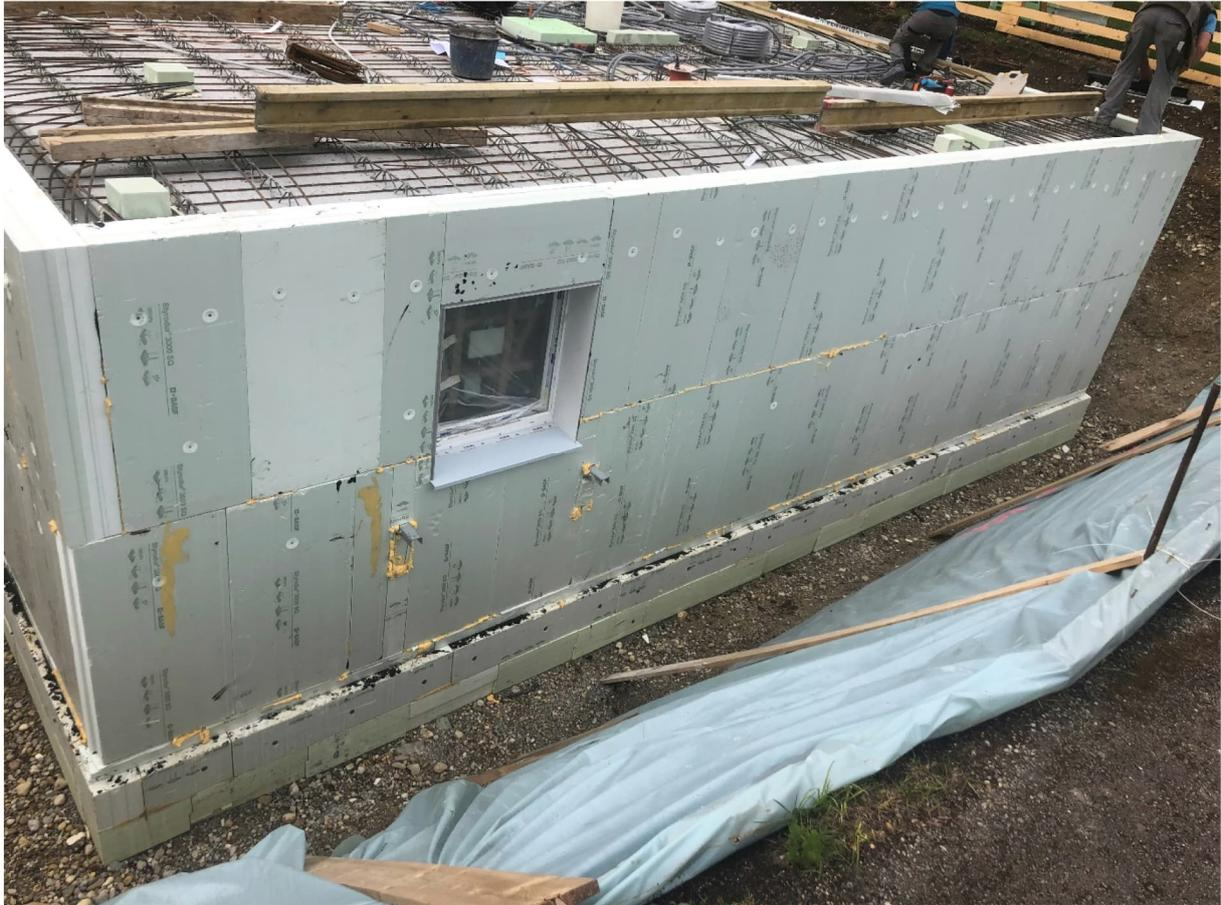
**Kelleraußenwand mit 2-lagiger XPS-Dämmung**
