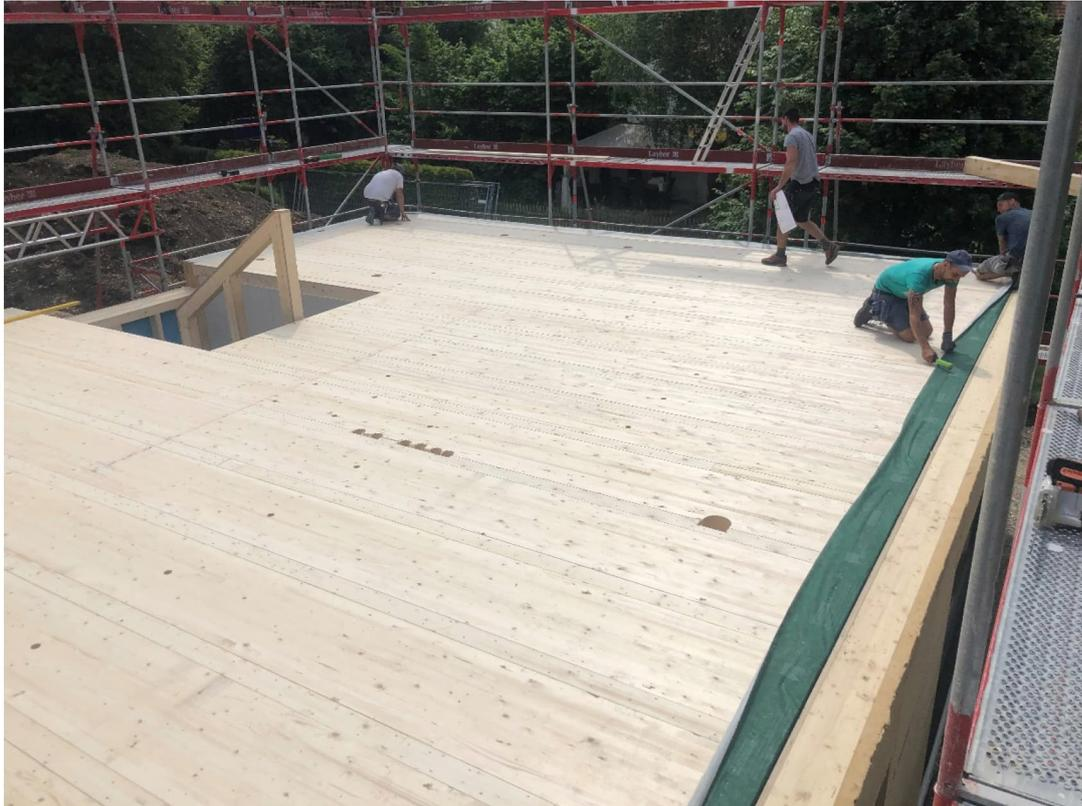
Hier ist der Übergang der Außenwand im Erdgeschoss auf die Geschosdecke vor Montage der Außenwand OG zu sehen. Die vormontierte Dampfbremse der EG-Wand wird über den oberen Rähm der Wand geschlagen und fixiert.
