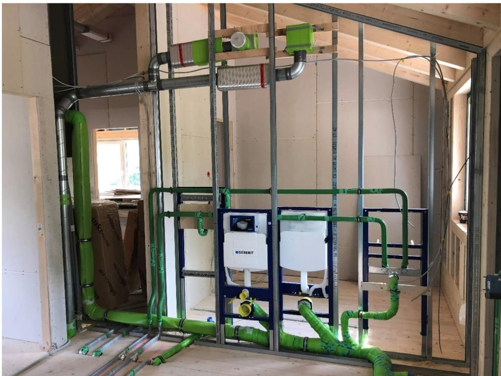
**Abluftleitungen mit Schalldämpfer in Installationswand zwischen den Bädern**
