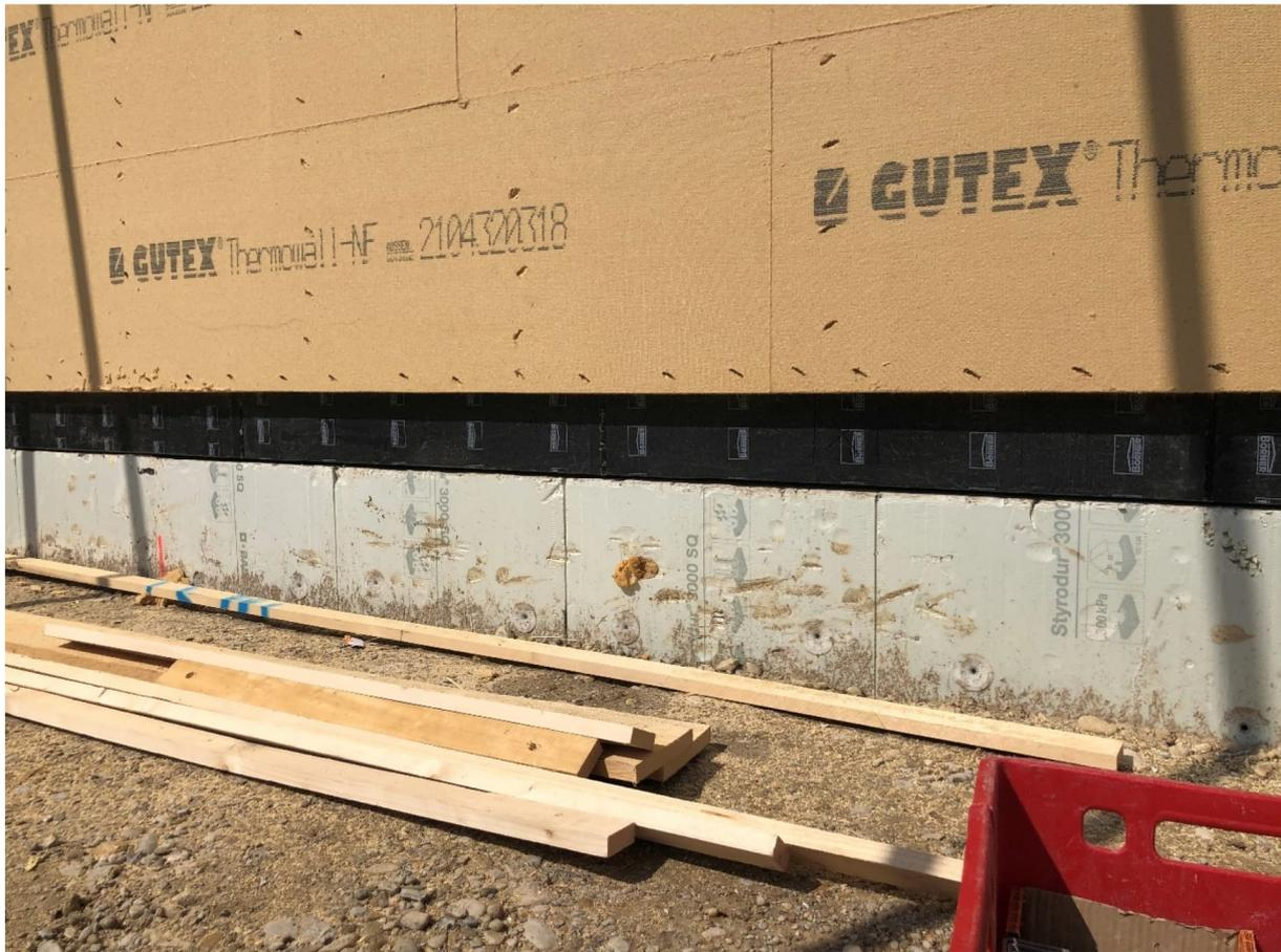
**Sockelabdichtung Börner Daco Thene an HD-Platte, Übergang zu Kelleraußendämmung PU und Holzbauwandaußendämmung Holzweichfaser**
