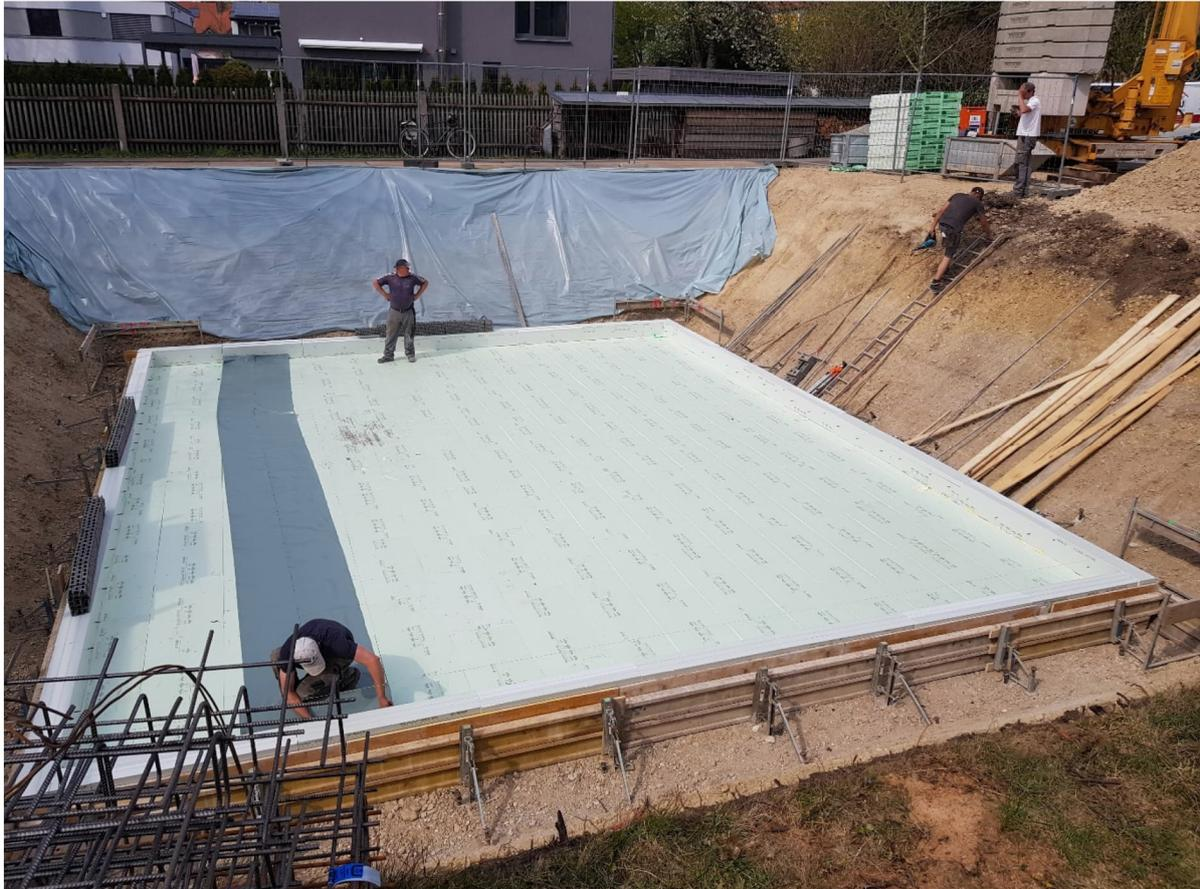
**Keller Rohbau – Dämmung unter der Bodenplatte**
