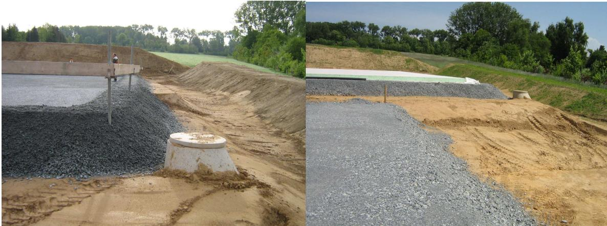
Das Haus wurde auf einer Bodenplatte gegründet, welche unterseitig mit einer rechnerisch 27 cm dicken, lastabtragenden Schaumglasschotter-Dämmung versehen ist. Zudem ist die Bodenplatte auch oberseitig mit einer 7 cm starken Dämmschicht unter dem Estrich versehen. Im Mittel wurde eine Schaumglasschotterschicht von 25 – 40 cm eingebracht.
