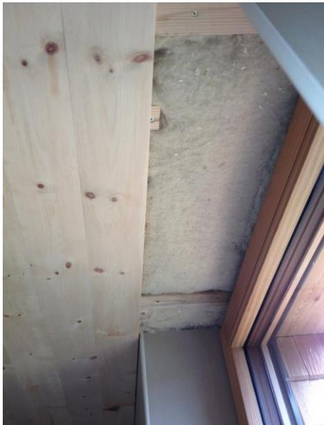
Die Holzfensterrahmen sind Außen flächenbündig. Der Einbau erfolgt mittels eines Blindstocks. Das Schienensystem für die Screen-Verschattung wird am Blindstock montiert. Eine Überdämmung des Fensters erfolgt auf der Innenseite mittels Schafwolle. Mit den rahmenlosen Fenstergläsern wird gleich vorgegangen.
