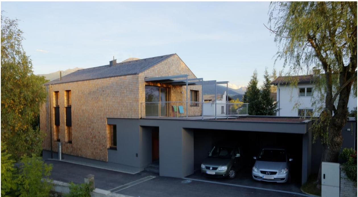
**Aufnahme Passivhaus EFH Natters von Nordwest**; kleine Fenster im Norden, in Höhe der Fenster im EG der Luftansaugturm der Lüftungsanlage.
