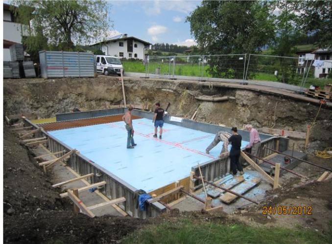
Anschluss Bodenplatte – Außenwand
