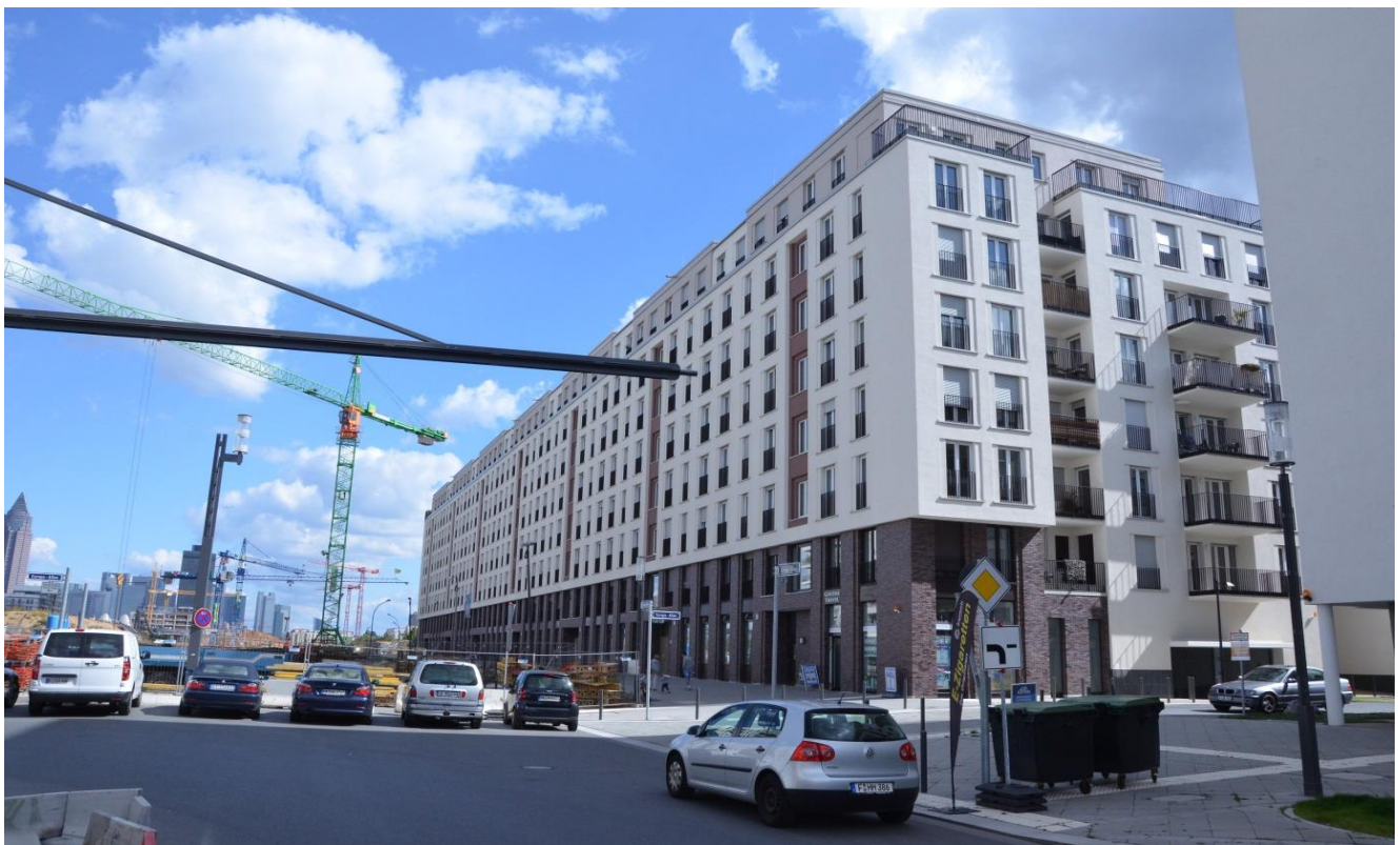
Ansicht von Westen, erkennbar ist das Staffelgeschoss
