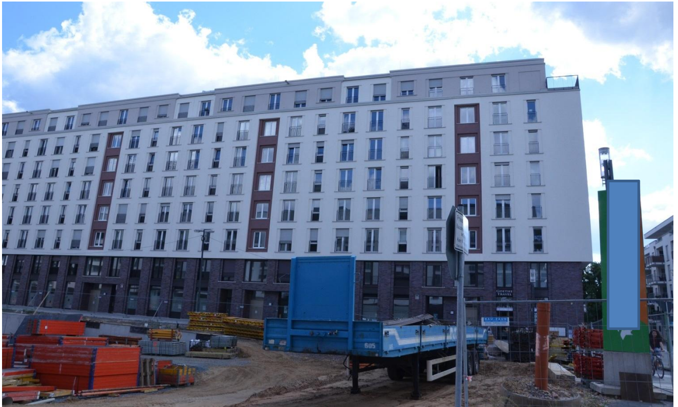
Nordansicht, in den Obergeschossen Wohnnutzung, im EG Gewerbenutzung
