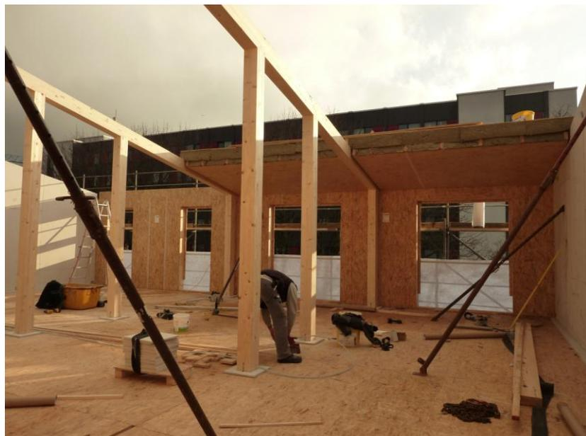
**Der Dachaufbau..** Das Dach wurde auch als Holzfertigteil auf der Baustelle und auf die Unterzüge montiert. Die Holzbalken von insgesamt 34 cm dicke wurden mit Steinwolle (WLG 035) vollgedämmt
