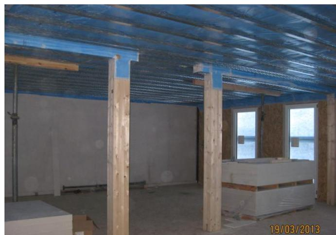
**Wohnungstrennwand:** Für die Luftdichtung im Bereich der Wohnungstrennwände wurden die Gipsfaserplatten, aus Brandschutz Gründe notwendig, ausgenutzt. Die Fugen wurden verputzt und die Anschlüsse an Wänden und Decken abgeklebt.
