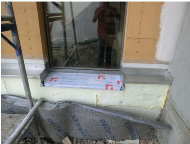
Einbau mit Rahmenüberdämmung
