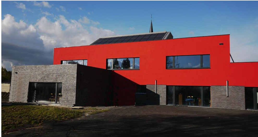
Façade Sud : De larges ouvertures horizontales sont disposées dans les salles de classe. On remarque l'alternance de matériaux de façade : briques de parement au RDC et enduit à l'étage.
