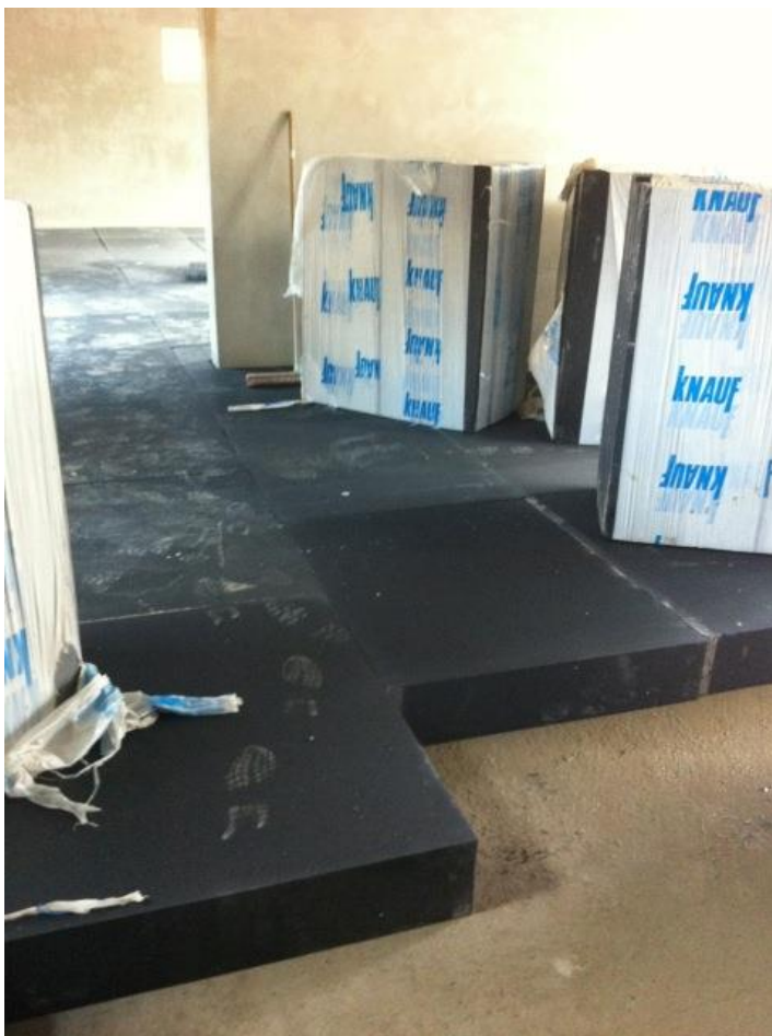
Photos lors de la mise en œuvre de l'isolant sous chape en PSE graphité
