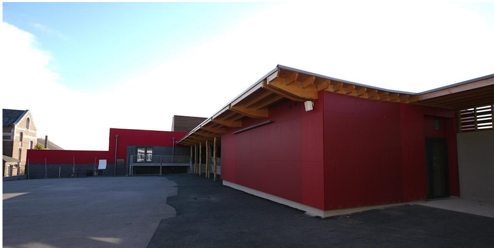
Façade Nord : Vue vers l'entrée, depuis les sanitaires extérieurs
