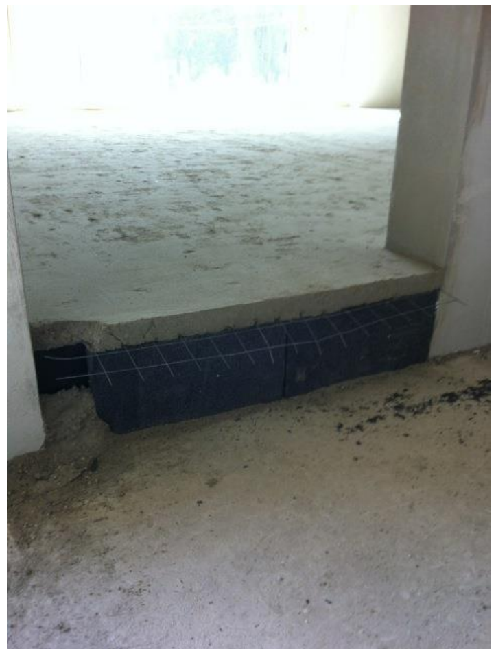
Photos lors de la mise en œuvre de l'isolant sous chape en PSE graphité
