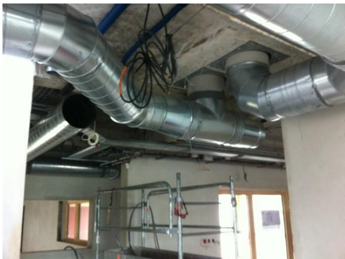
Le réseau de ventilation en cours de pose
