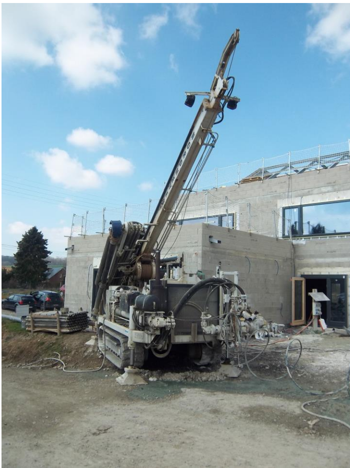
Photos prises lors des forages des sondes géothermiques
