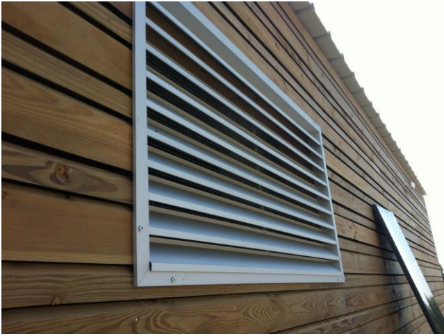
Prise d'air et rejet du local technique en toiture
