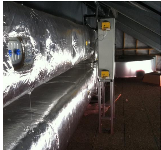
Prise d'air et rejet du local technique en toiture
