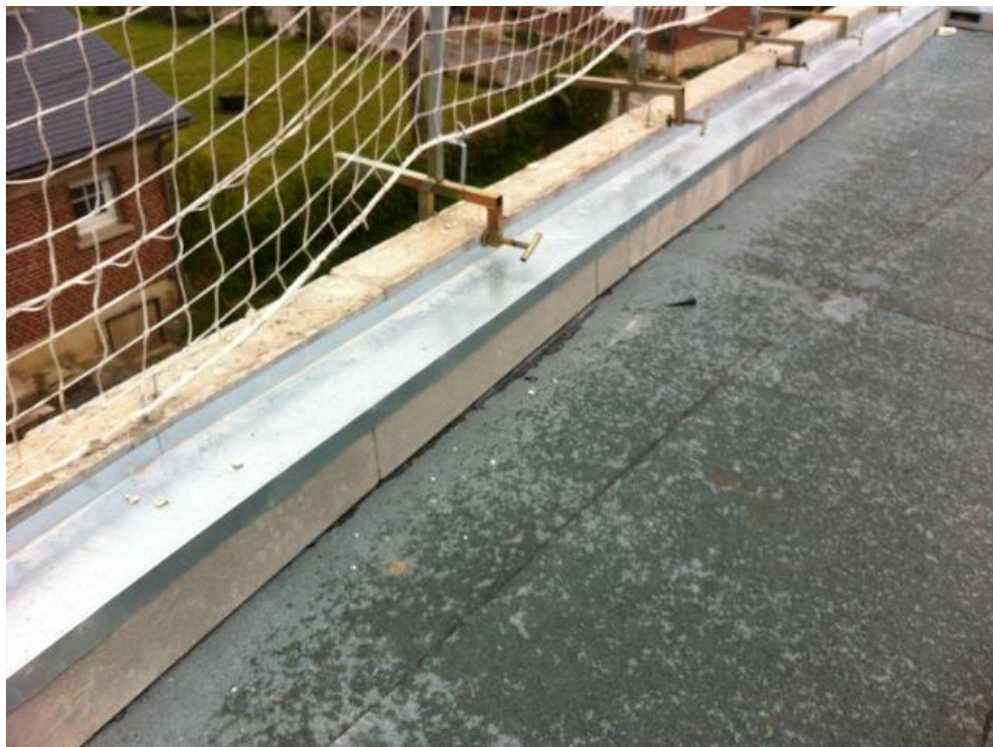
Détail de la composition de toiture et vue de la toiture après pose de l'étanchéité (avant traitement de l'acrotère)
