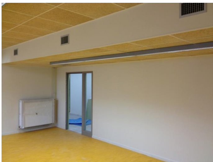
Plénums de soufflage / reprise dans les classes
