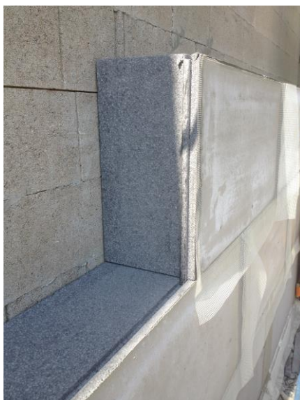
Photo de l'isolation extérieure du mur / Modélisation du raccord mur/mur
