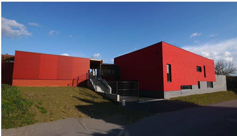
Façade Ouest : Vue sur les ouvertures de la salle d'évolution
