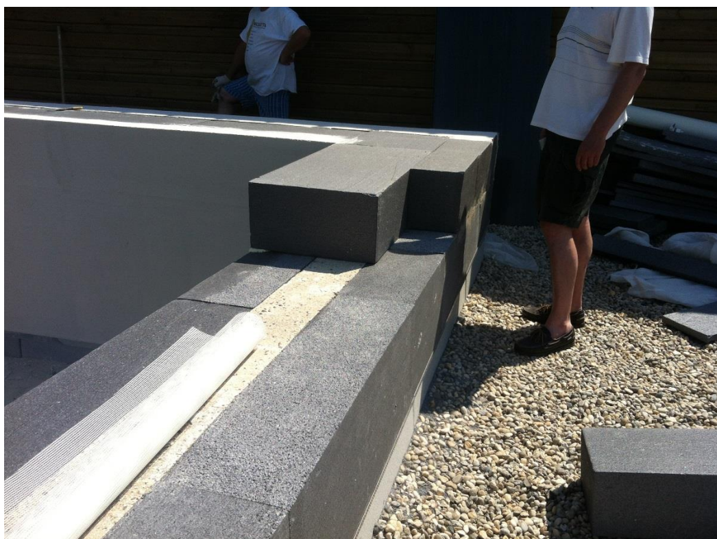
Coupe de principe et photo au niveau de l'isolation 3 faces de l'acrotère
