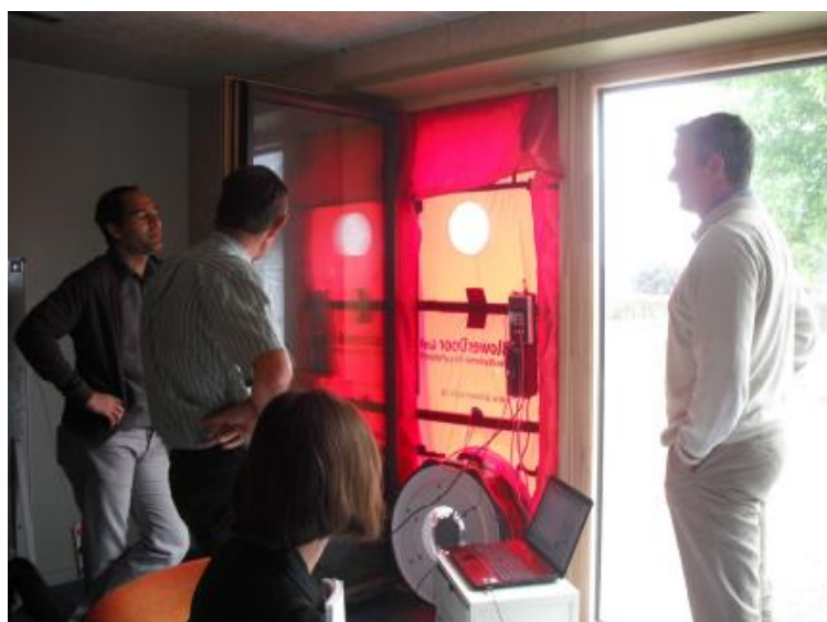
Le test d'étanchéité à l'air final
