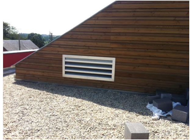
Prise d'air et rejet du local technique en toiture
