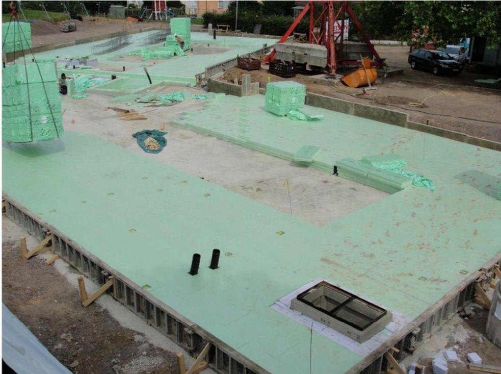
**Abbildung 21:** Verlegung der Wärmedämmung unter der Bodenplatte
