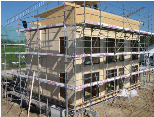
Außenwände mit teilweise eingesetzten Fenstern und Türen
