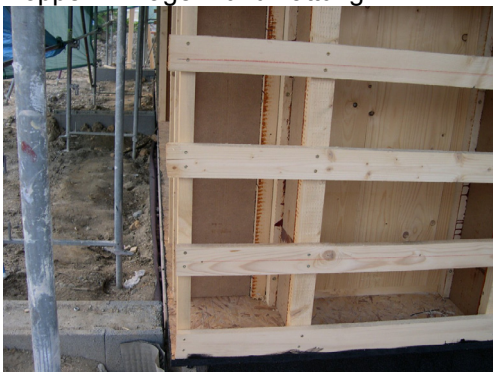
Außenwände mit montierten Doppel-T-Trägern und Lattung
