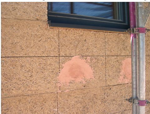
unverputzte Heraklithfassade nach dem Verschließen der Öffnungen für die Einblasdämmung
