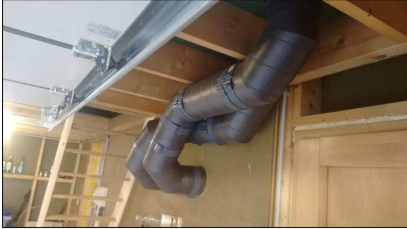
Sur la photo ci-dessous on aperçoit les deux collecteurs reliés à la centrale avec les différentes gaines distribuant l'air tempéré d'un côté et aspirant l'air vicié de l'autre.
