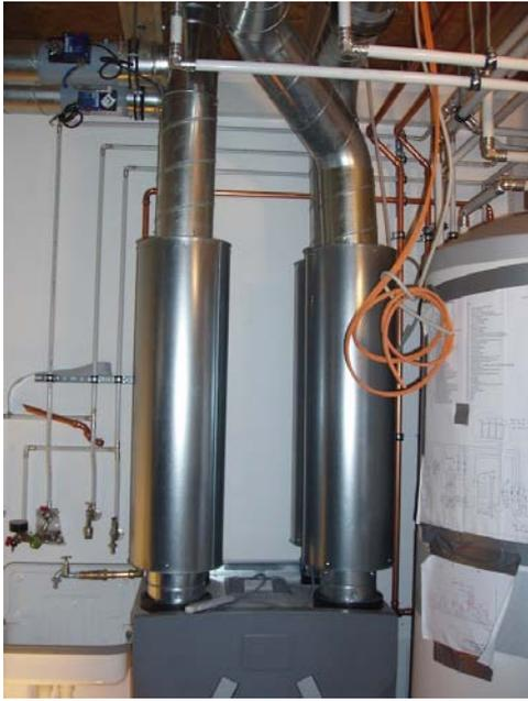
Lüftungsanlage (unten) mit senkrecht sitzenden Schalldämpfern, noch ohne Dämmung
