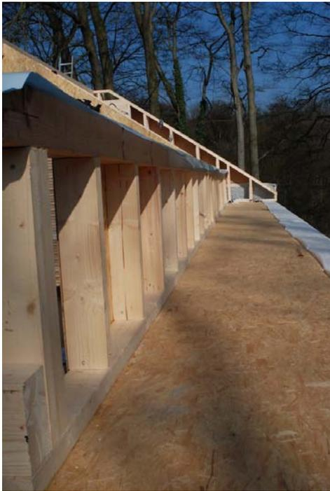
Holzbau - Abseite Dachgeschoss mit vorbereiteter Luftdichtheit in Form von Folienstreifen (auf dem Foto weiss und hellblau) vor Einbau der Dachsparren.
