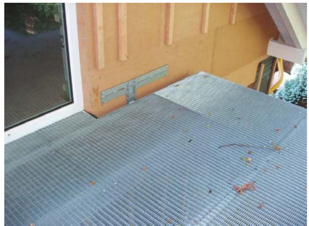
Wärmebrückenfreie Schwingungsbefestigung des Stahlbalkons, bevor die Fassade mit Holzschalung fertiggestellt wird.
