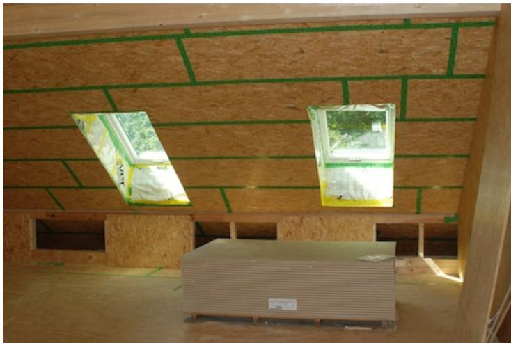
Dachflächenfenster, von innen luftdicht eingeklebt mit Folienanschlüssen.
