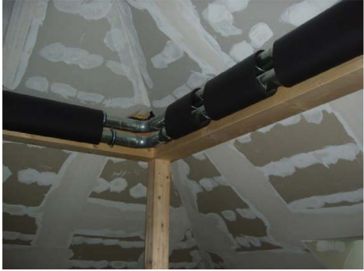
Lüftungsrohrverlauf im Dachgeschoss im Bau, Rohrisolierung bereits teilweise montiert. Die Rohe wurde später mit einem Kasten verkleidet
