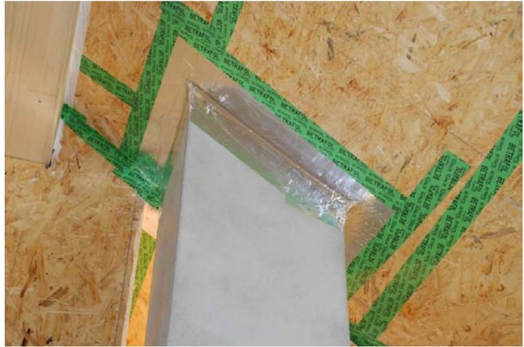
Luftdicht geputzter Schornstein mit Folienanschluss zur OSB-Platte des Daches
