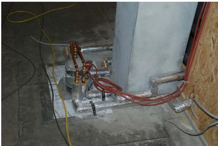
Vorbereitung des wasserführenden Ofens auf der Rohsole, mit geputztem Schornstein, der später noch gedämmt wurde
