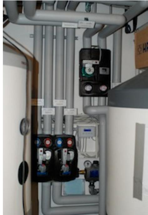
Pumpenmanagement für Heizung, Warmwasser und thermischer Solaranlage zwischen den Speichern
