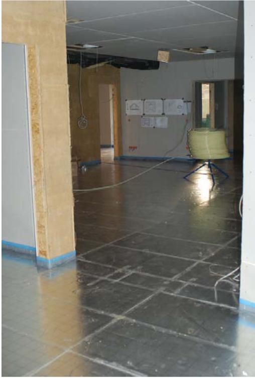
Verlegte Fußbodendämmung, alukaschiert und Beginn der Verlegung der Fußbodenheizung. Im Hintergrund an der Decke die Messampel
